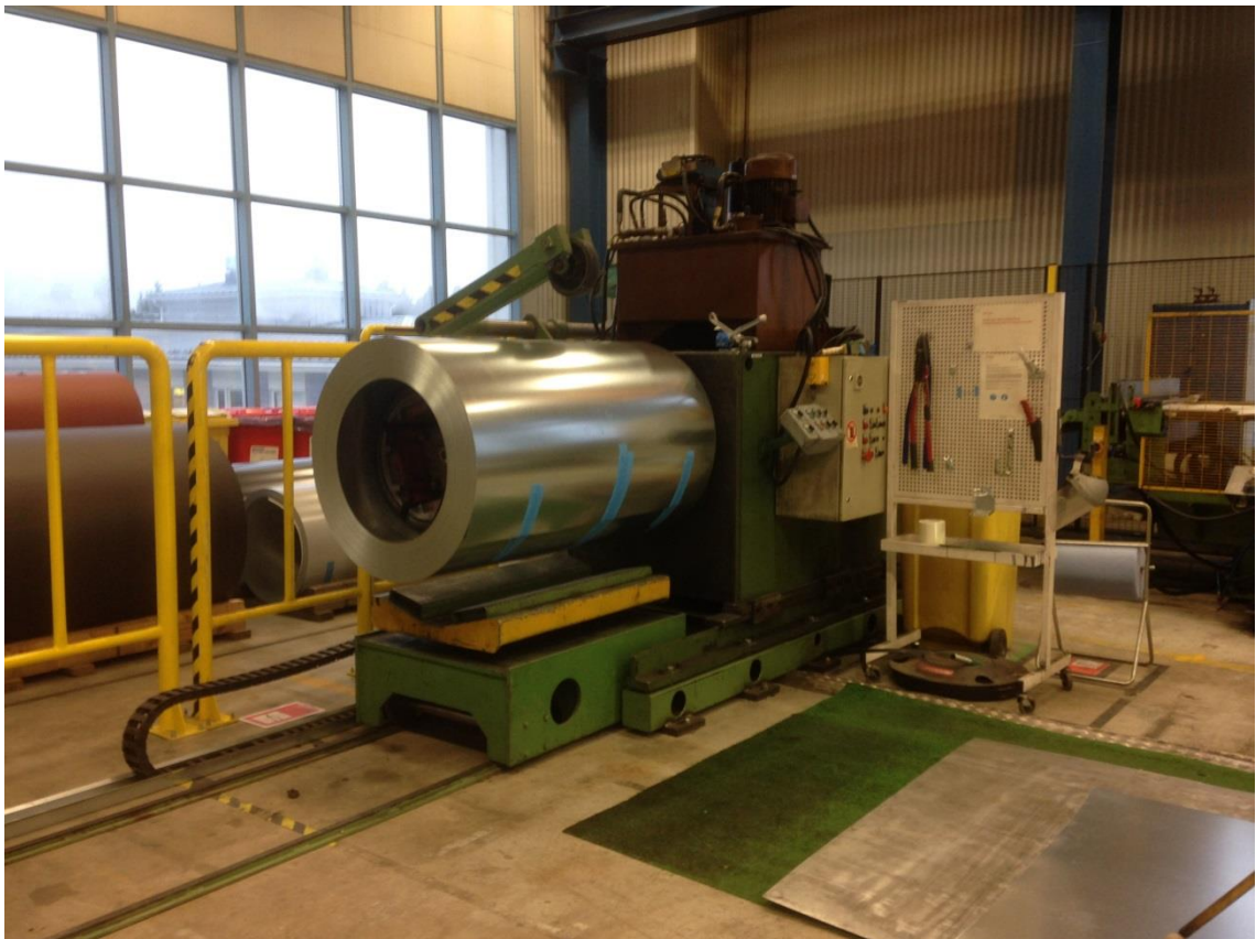
KUVA 2. Teipattu peltikela painorullan ollessa ylhäällä (Kuva: Joonas Viitala 2014)
