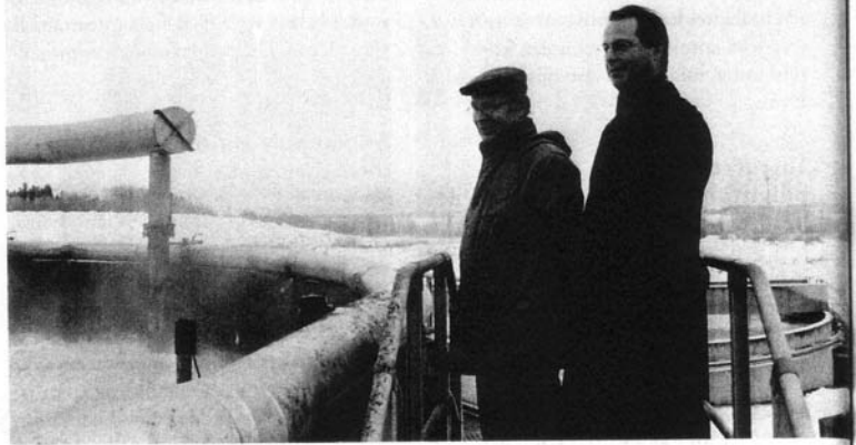
Lielahden tehtaiden tekninen johtaja Ole Nickull (vas.) ja MetsoPaperChem'in vedenkäsittelyjärjestelmien myyntipäällikkö Ilkka Laasonen luovutuspalaverin jälkeen uuden laitoksen reunalla.
