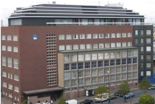
Kuva 5 Sähkötalo Kamppi, Helsinki
