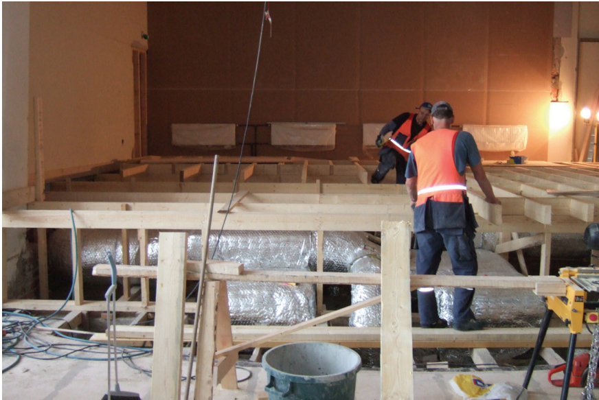
Kuvio 4: Näyttämörakenteen kannen tekoa. IV-kanavat on jo asennettu ja eristetty (Kuva: Topi Salminen)
