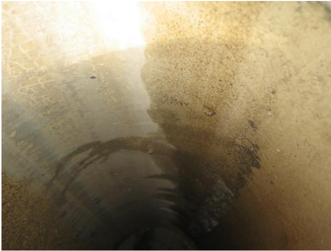
Kuva 17 Virheettömässä kunnossa oleva, sisäpuolelta betonilla pinnoitettu putki.
