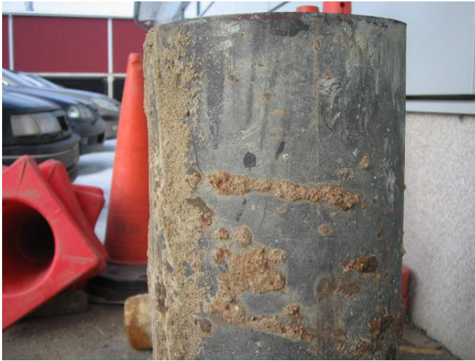
Kuva 16 Hyväkuntoinen, kuivaan maaperään asennettu putki.
