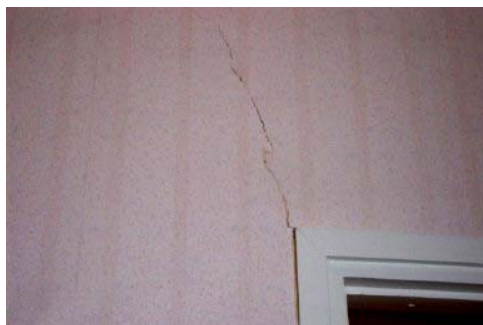
Kuva 21. Pinkopahvin ja tapetin repeämä.
