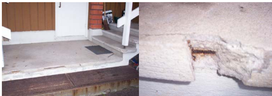
Kuva 8. Pääsisäänkäynnin portaat ja rauditus.
