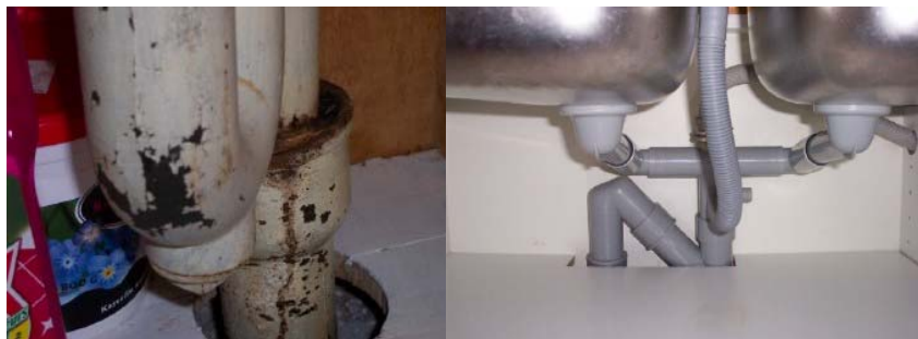
Kuva 25. Vanha ja uusi vesilukko
