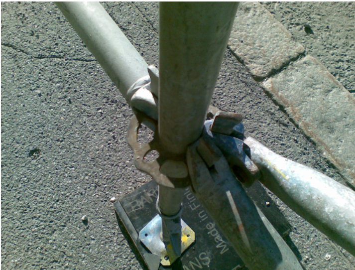
Kuva 5 Allround-telineen liittosysteemi
