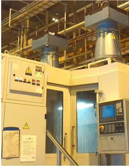
Kuva 4. Työstökeskus ja huoneilmaan palauttava järjestelmä. Sandvik Mining Oy, Myllypuro.
