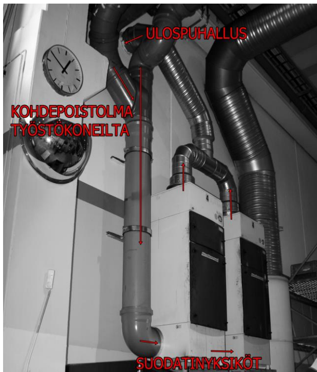
Kuva 2. Leikkuunestekohdepoiston ulospuhallus. Valtra Oy, Suolahti.
