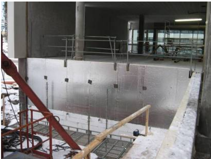
Kuvio 47: Torninosturin ja rakennuksen välinen kulma (Kuva: Teemu Saari)
