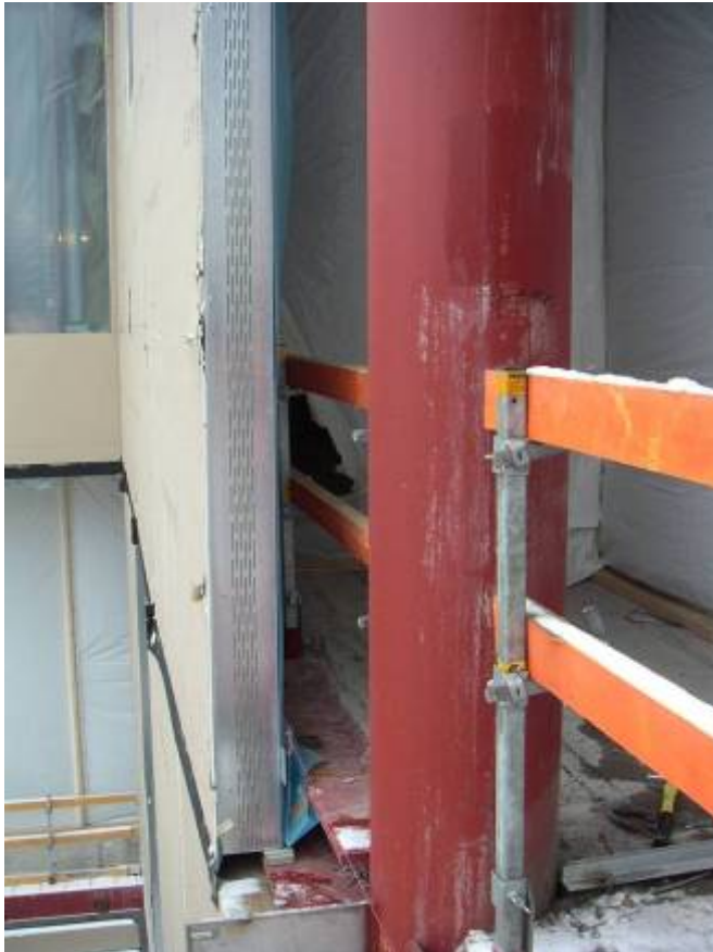
Kuvio 7: Kaiteet poistetaan vasta seinäelementtien asennuksen jälkeen. Huomioitavaa on, että jalkalista on poistettu kaiteesta ja välijohteiden lyöntilukot on lyöty auki. (Skanska Talonrakennus Oy, 2009)
