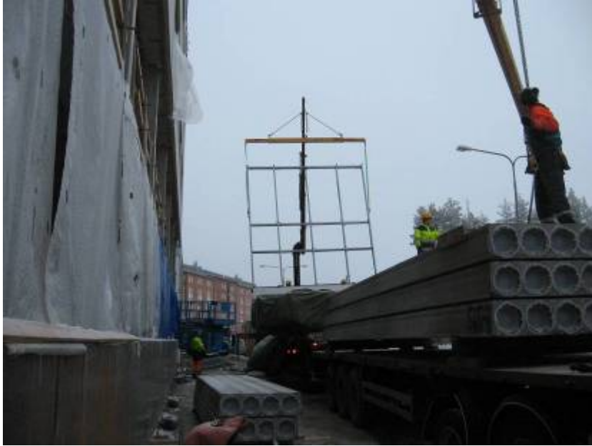
Kuvio 54: Ontelolaattoja ja julkisivuelementtejä nostellaan samaan aikaan (Kuva: Teemu Saari)
