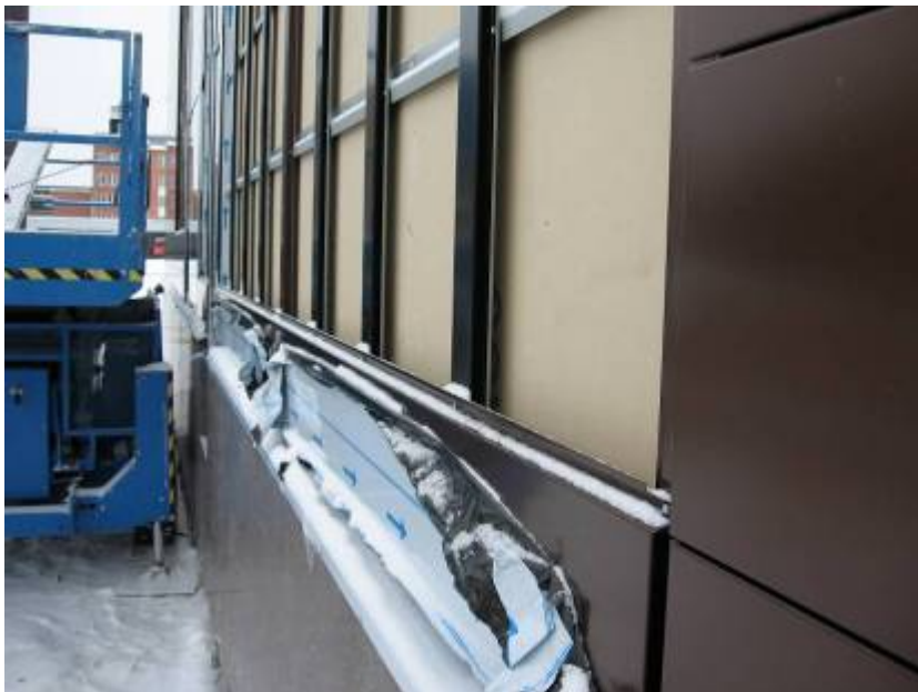
Kuvio 36: Vaaka-, pystykoolaus ja julkisivukasetti asennettuna Tehoranka-elementtiin (Kuva: Teemu Saari)
