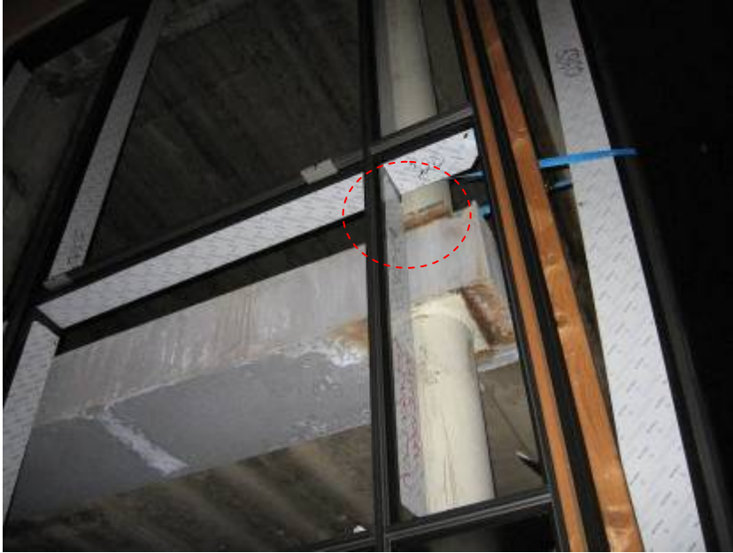
Kuvio 56: Pilarin pohjalevy julkisivun linjalla (Kuva: Teemu Saari)
