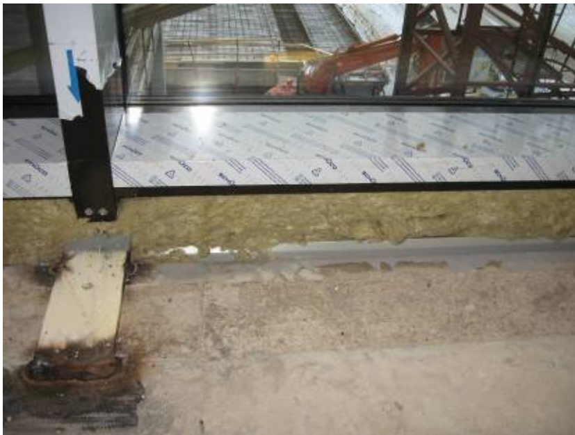
Kuvio 32: Villatilojen välit tiivistetään vuorivillalla (Kuva: Teemu Saari)
