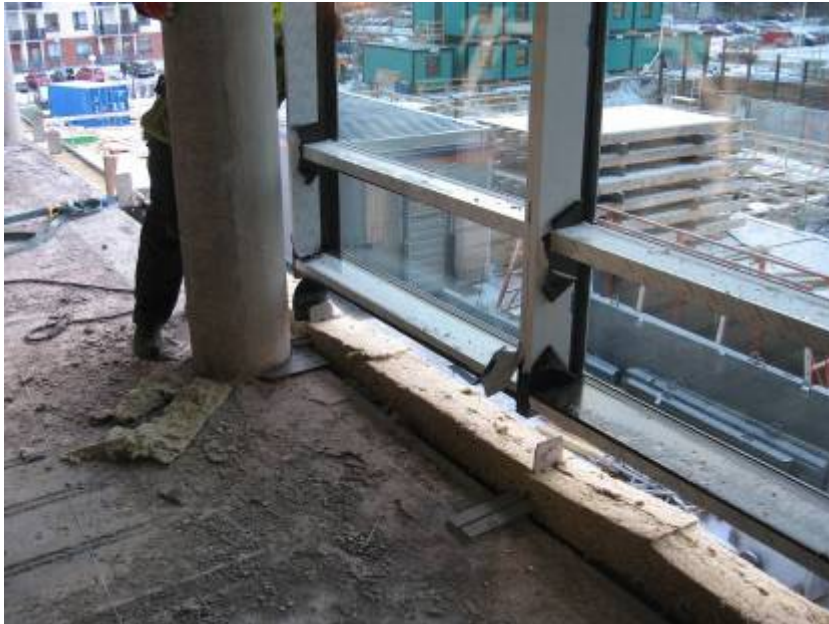
Kuvio 28: Elementin alapään varaukset lasketaan edellisen elementin puukkoihin. Liitos on erittäin tiukka, joten tässä kannattaa onnistua kerralla. Vuorivillatiivistys kannattaa asentaa tässä vaiheessa. (Kuva: Teemu Saari)
