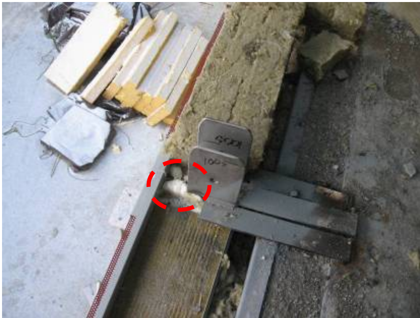
Kuvio 31: Alumiinirunkoisten lasielementtien pystysauma tilkitään yläpinnasta uretaanilla, jottei hormivaikutusta pääse syntymään (Kuva: Teemu Saari)
