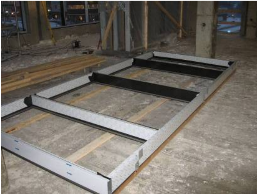
Kuvio . Alumiini-ikkunat holvilla asennusta valmiina asennusta varten (Kuva: Teemu Saari)
