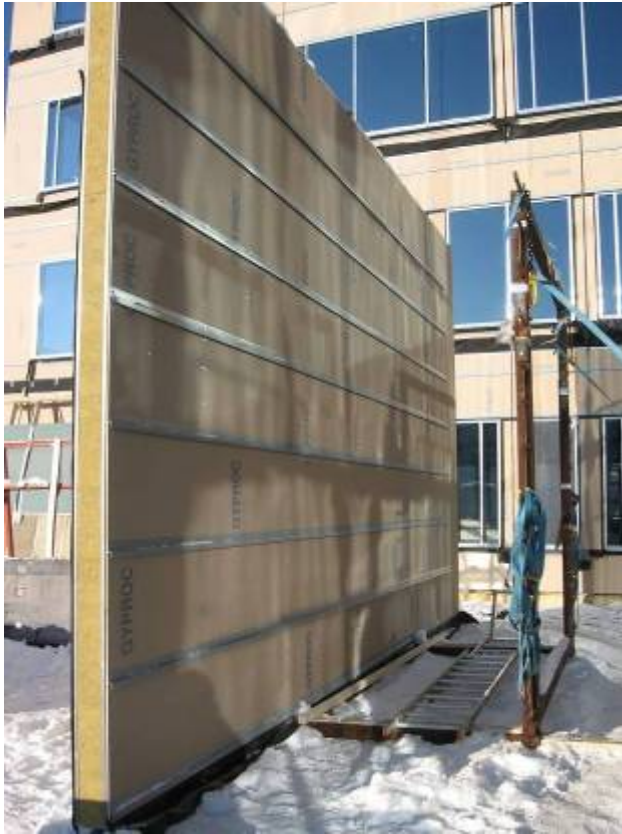
Kuvio 35: Elementti on toimitettu vaakakoolauslistat asennettuna työmaalle (Kuva: Teemu Saari)
