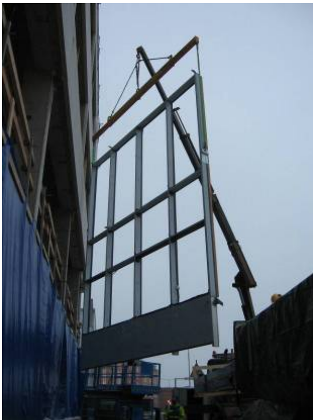
Kuvio 21: Elementin rakenteesta johtuen on joskus edullisinta nostaa se suoraan autosta paikalleen (Kuva: Teemu Saari)
