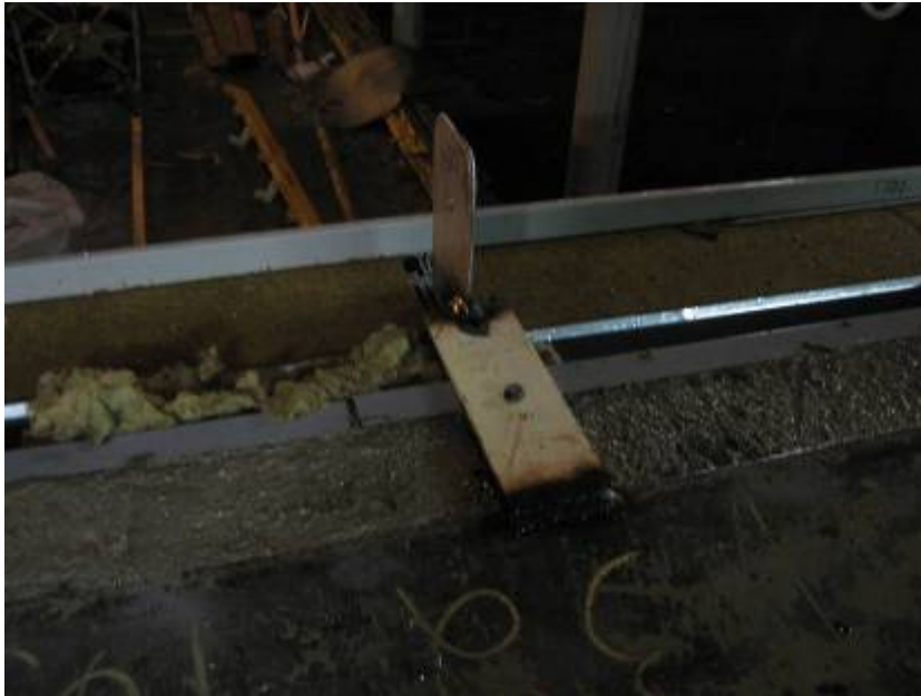
Kuvio 26: Elementti on liitetty kiinni deltapalkkiin lattateräksen. Latan keskellä oleva betoniruuvi varmistaa liitoksen kestävyden (Kuva: Teemu Saari)
