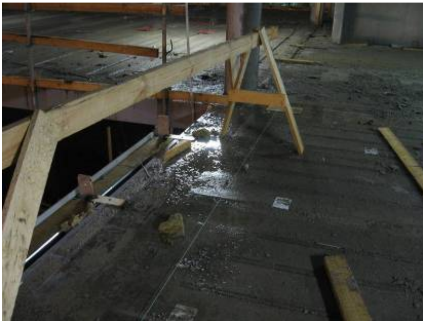
Kuvio 22: Moduulilinjasta on otettu tietty mitta sisäänpäin, ja se on merkitty holviin kiinnitettyihin vanerilappuihin lyödyillä nautoilla. Naulojen väliin kiristetään linjalanka, josta voidaan katsoa elementin oikea etäisyys (Kuva: Teemu Saari)
