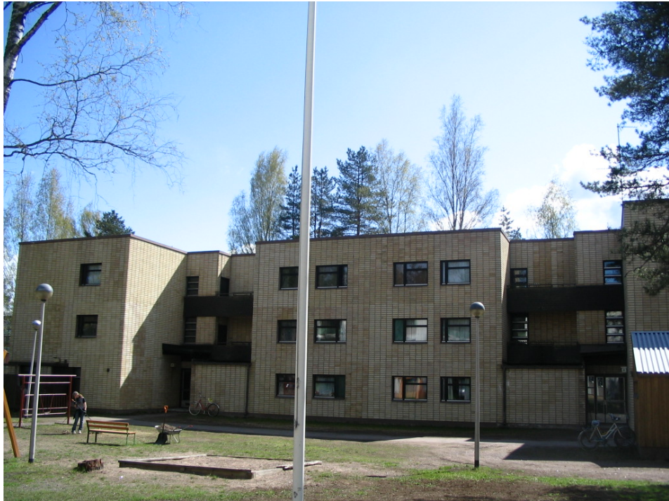
Kuva 2 Patteritie 2 julkisivu pohjoisesta päin katsottuna
