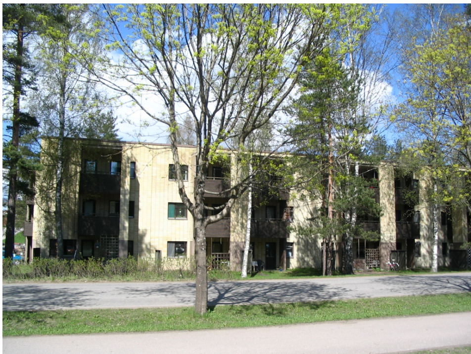
Kuva 3 Patteritie 2 julkisivu etelästä päin katsottuna
