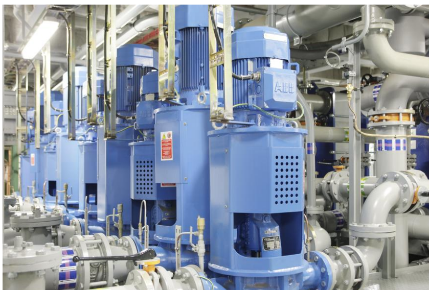
Kuvio 11. ABB M3-moottoreita pumpun moottoreina M/S Viking Gracella.
