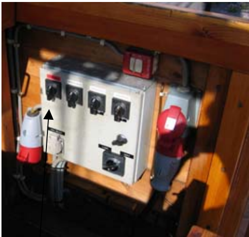
Palopumpun käyttökytkin
