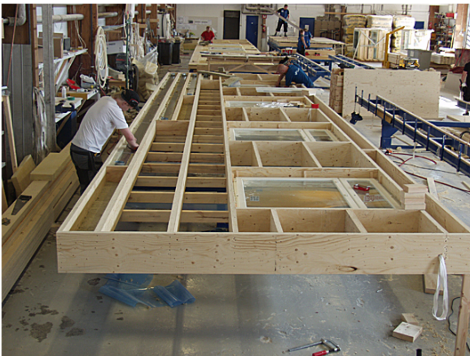
Kuva 5. Elementtien valmistusta Teeri-kolmion tehtaalla [9].
