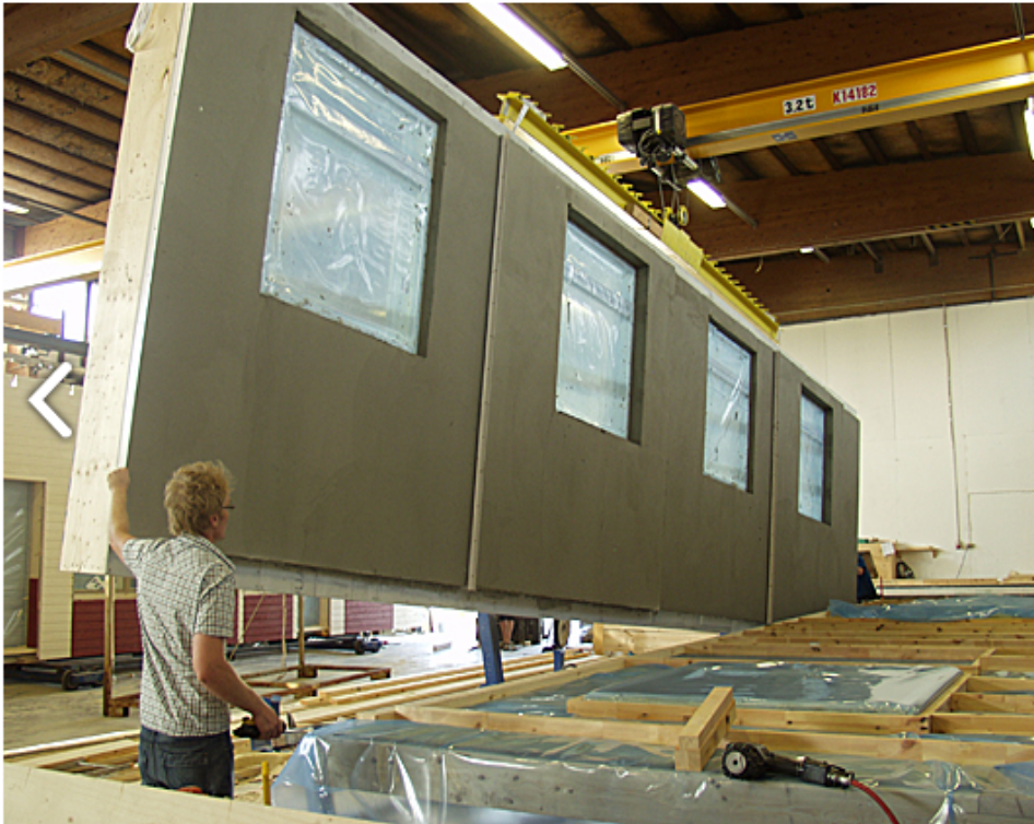
Kuva 4. Elementtien valmistusta Teeri-kolmion tehtaalla [9].
