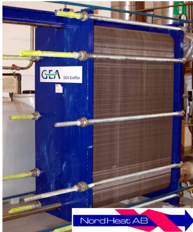
Figur 6: Plattvärmväxlare (8)
