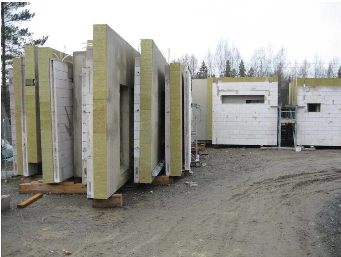
Kuvio 19. Valmiit elementit odottamassa kuljetusta työmaalle (Kuva: Lauri Pöyhönen)
