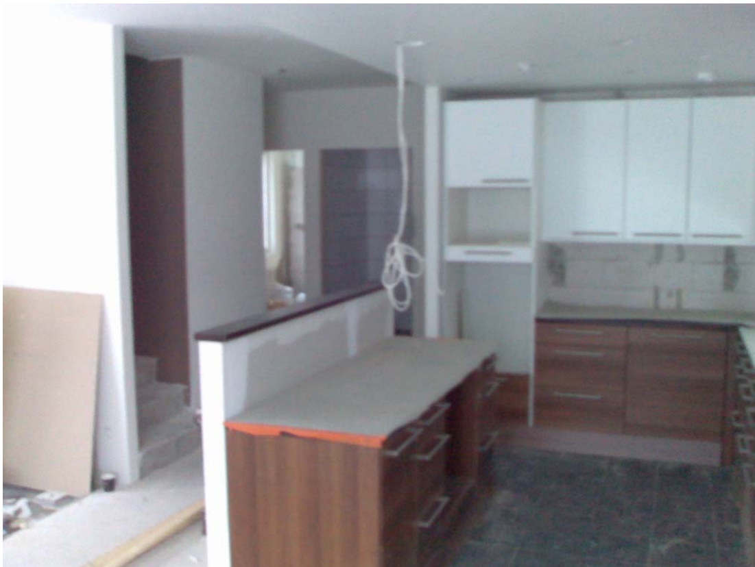
Kuvio 28. Ensimmäisiä keittiöitä kalustusvaiheessa (Kuva: Lauri Pöyhönen)
