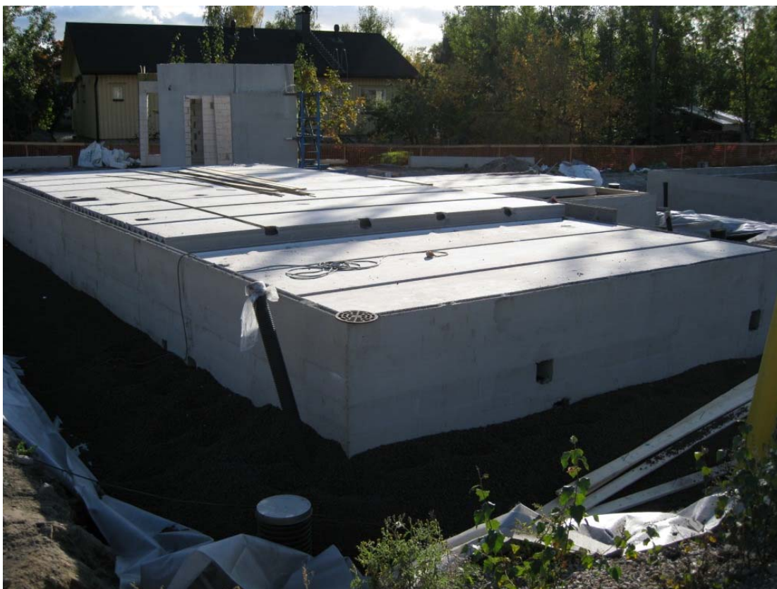
Kuvio 24. Riddarsby 25.9.2008. Ensimmäisen talon alapohjan ontelolaatat asennettuna (Kuva: Lauri Pöyhönen)
