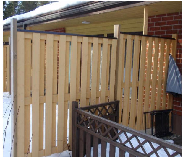
Kuva 6: Huoneistojen välinen terassiaita on hyvässä kunnossa.
