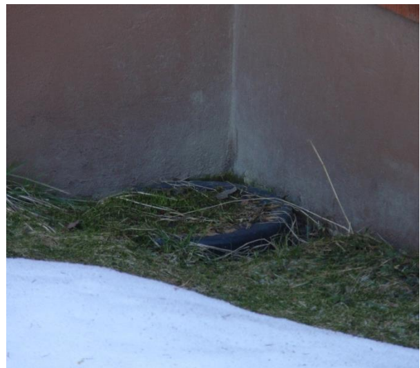
Kuva 2: Kuvan 1 sokkelin kulmassa on salaojan tarkastuskaivo.
