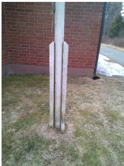
Kuva 1: Vesi ja lumet jäävät seisomaan seinän nurkkaan.
