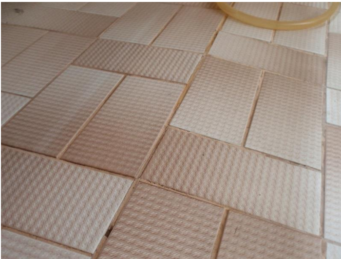
Kuva 33: Pesuhuoneen lattia on vaarallisen jyrkkä.
