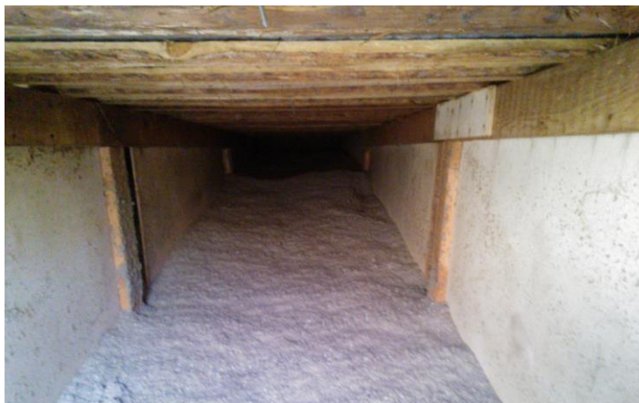
Kuva 22: Räystäälle päin. Tuulettuvuus voi olla puutteellinen.
