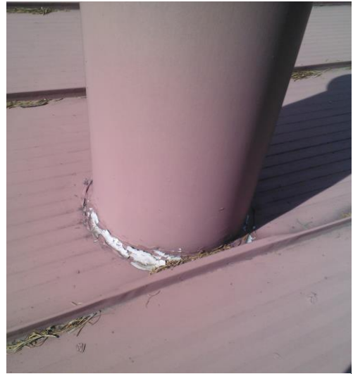
Kuva 24: Lämpivientien sauma-aine on paikoin halkeillut.
