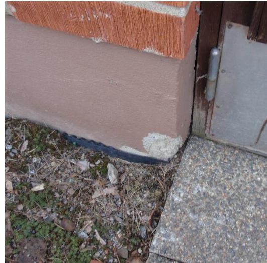
Kuva 12: Sokkelissa halkeama. Kuvassa oleva halkeama on havaituista halkeamista huonoimmassa kunnossa.
