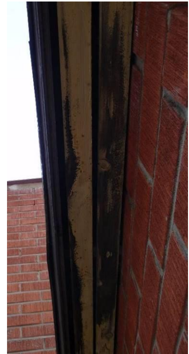
Kuva 27: Rästaslaudoissa on havaittavissa puutteellista tuuletumista alakatteen tummentumana.
