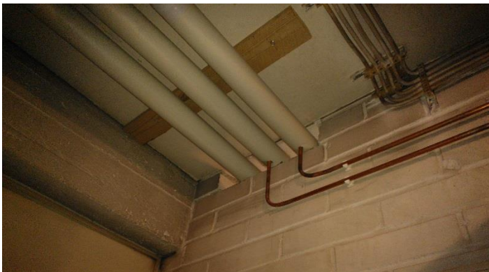
Kuva 35: Palokatkot ovat puutteelliset läpivientien kohdalta.
