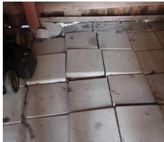
Kuva 8: Pyörävarastossa on maanpinnan routimista.
