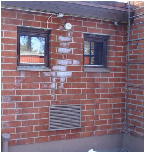
Kuva 13: Itäisen julkisivun seinä teknisen tilan kohdalta savupiipun vasemmalta puolella, joka vaatii lisätutkimuksia.
