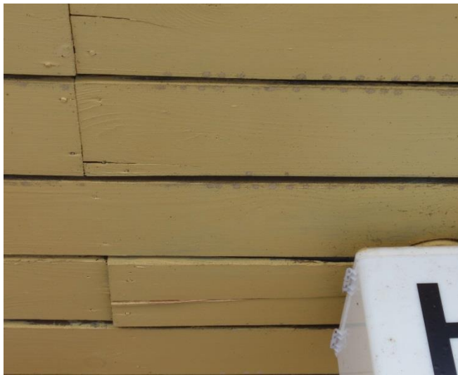
Kuva 28: Rästaslaudat ovat paikoin irronneet,
