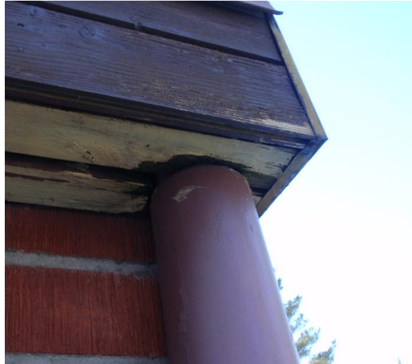
Kuva 30: Syöksytorvi menee räystäslautojen läpi. Itäinen julkisivu.
