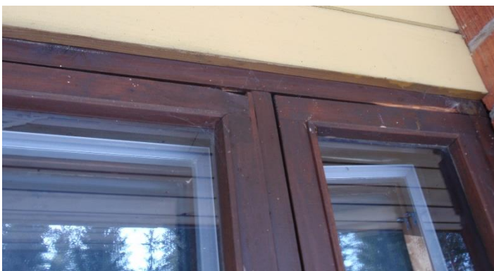
Kuva 17: Ikkunoissa on paikoin havaittavissa liikkumista.
