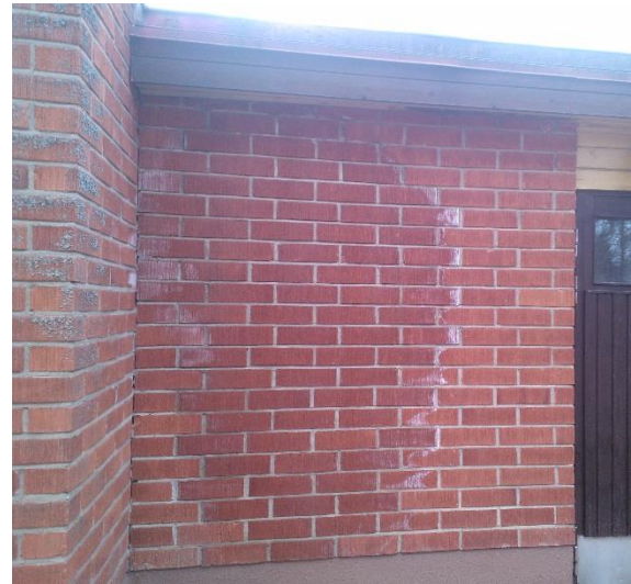
Kuva 14: Itäinen julkisivu piipun oikealta puolelta, joka vaatii lisätutkimuksia. Kuvassa näkyy myös piipussa oleva jäkäläkasvusto.
