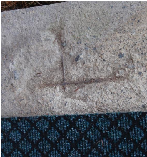
Kuva 5: Sisääntulon betonilaatasta näkyvät teräkset.
