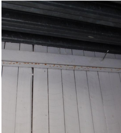
Kuva 7: Roskakatoksen teräsosissa olevaa pintaruostetta.
