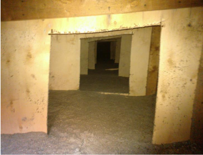
Kuva 21: Yhteisten tilojen kohdalle on tehty vaneriuuma-palkkeihin aukot ja palokatkot ovat puutteelliset teknisen tilan kohdalla.
