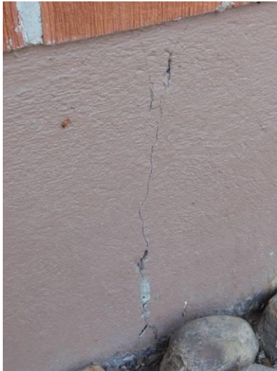
Kuva 11: Oven vieressä sokkelissa haivattu halkeama.
