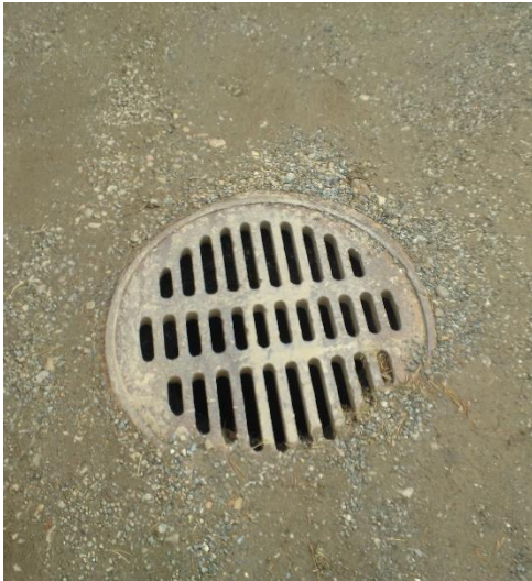
Kuva 3: Sadevesikaivo on liian korkealla, jolloin hulevedet jäävät kaivon ympärille.
