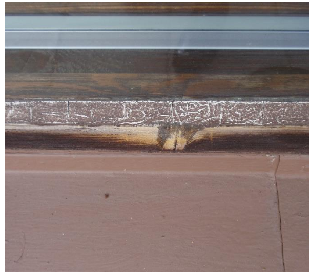
Kuva 16: Ikkunakitit ovat halkeilleet.
