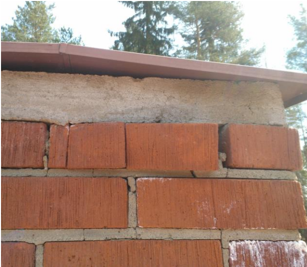
Kuva 23: Savupiipun muurauksen ja tiilien lohkeilua.
