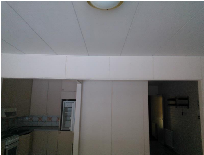
Kuva 25: Huoneiston E painuma on havaittavissa kuvan keskellä.
