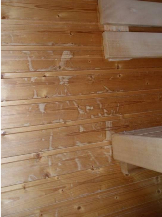
Kuva 31: Saunan paneeleissa on kosteusjälkiä.
