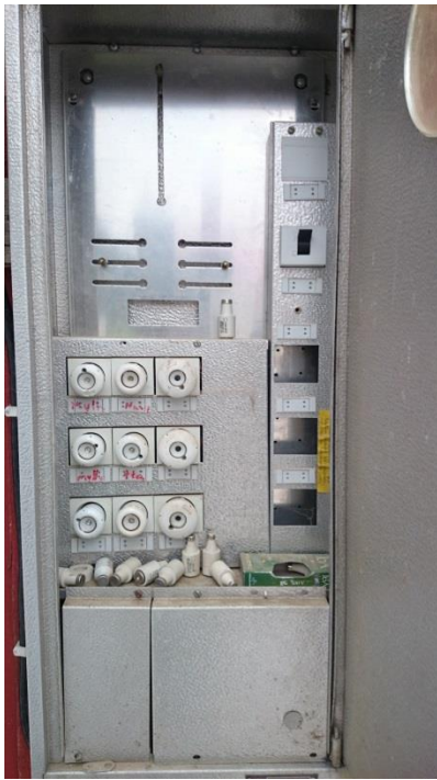
KUVA 11. Ryhmäkeskus 1 toiminut aikoinaan pääkeskuksena.
