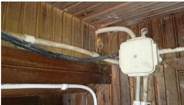
KUVA 14. Kytkentöjä tehty kumikaapelilla (Arttu Honkanen 2015-20-2).
