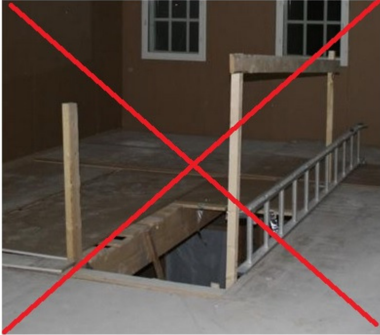
KUVA 3. Puutteellinen putoamissuojaus porrasaukossa (15)
