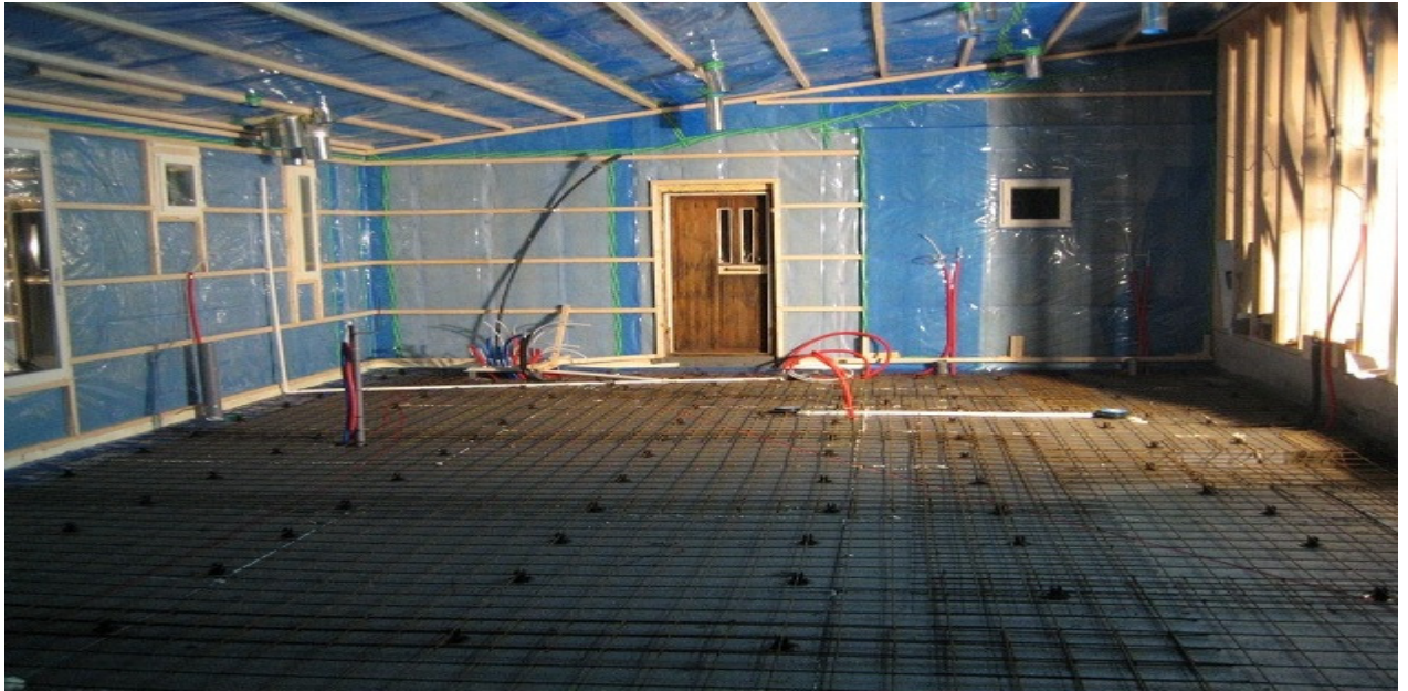
KUVA 8. Lattiaverkon korotuskorppuja asennetaan noin 4 kpl/m 2 (15.)
