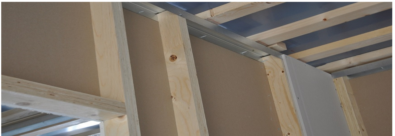
KUVA 9. Valmis seinärunko. Yläjuoksun paikka on merkitty kattokoolauksiin värilangalla (15)
