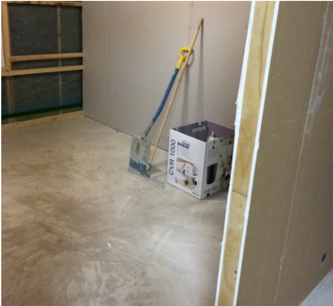
KUVA 4. Siisti työmaa on työn tehokkuuden ja laadun kannalta tärkeä asia (15)
