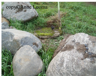
Kuva 11. Viemärikaivon kansi maanpinnan tasalla.
