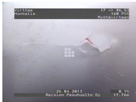
Kuva 17. Rakennetun viemäriinjan kuvaus ennen viemärin käyttöönottoa, jossa kiven aiheuttama halkeama.
