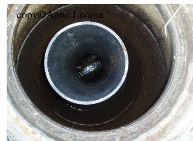
Kuva 10. Ulkopuolella oleva vesi ei ole päässyt kaivoon.
