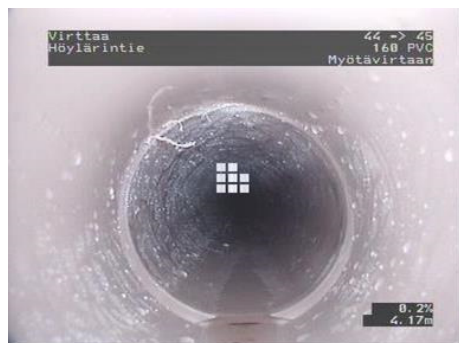
Kuva 18. Rakennetun viemäriinjan kuvaus ennen viemärin käyttöönotto, jossa putkien liitoskodassa juuri.
