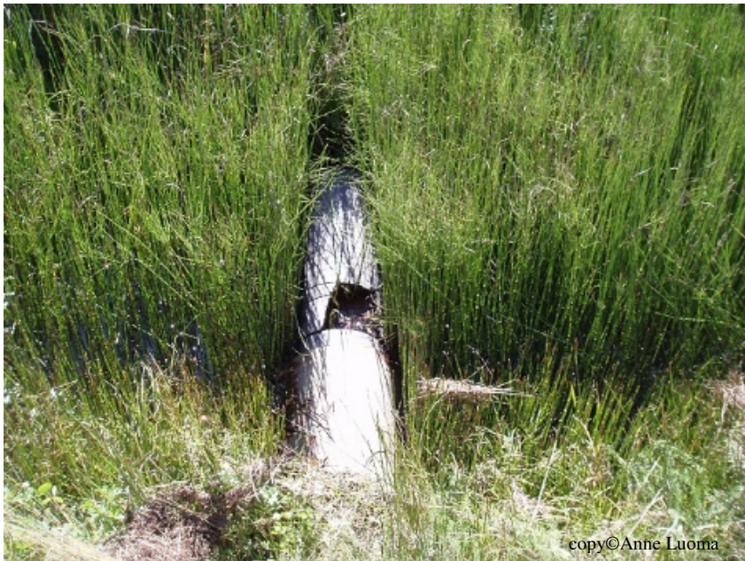
Kuva 3. Raviradan kuivatuksen purkuputki
