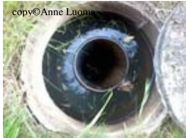
Kuva 7. Sujuttamalla saneerattu viemäri, jossa vesipinta melkein kaivon reunan tasolla.
