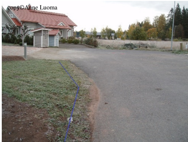
Kuva 21. Rakentamisen jälkeen tehty ojatäyttö. Sininen viiva kuvaa ojan paikkaa.
