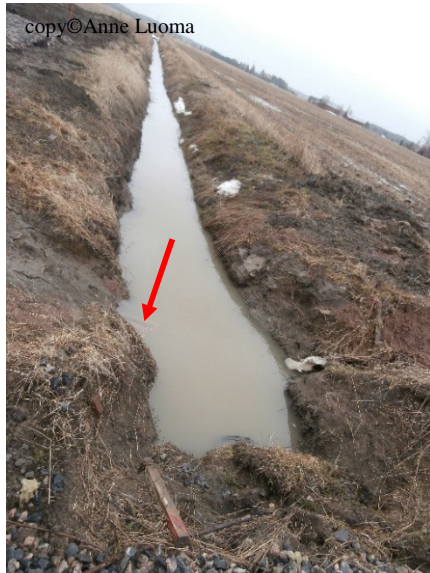
Kuva 14. Tiiran alueelta pumppaamon purkuputki.
