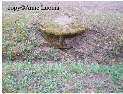
Kuva 13. Viemärikaivo, jonka renkaiden välissä kädenmentävä aukko.
