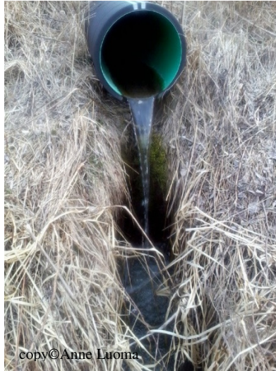
Kuva 20. Uitontien rumpu, johon tulee uitontien ja tiiranalueen sadevedet.
