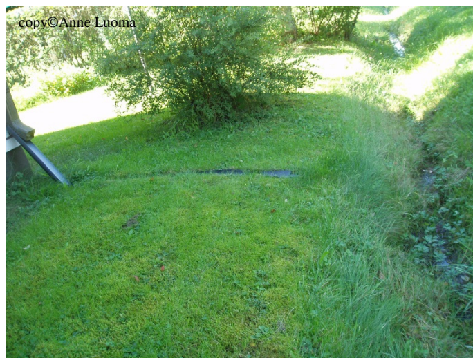
Kuva 24. Katolta tulevien sadevesien ohjaaminen pintakourujen kautta avo-ojaan.
