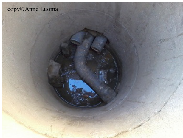
Kuva 15. Tontilla oleva viemärikaivo, jossa tarkistusaukko on tehty y-haarasta.
