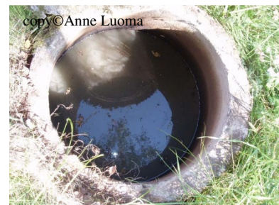
Kuva 9. Kaivon läpi kulkee viemäri- ja kaivolinjojen tontti-johto.
