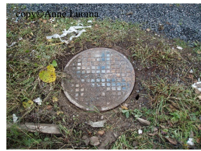
Kuva 12. Viemärikaivon kannen kaulus on kulunut puhki
