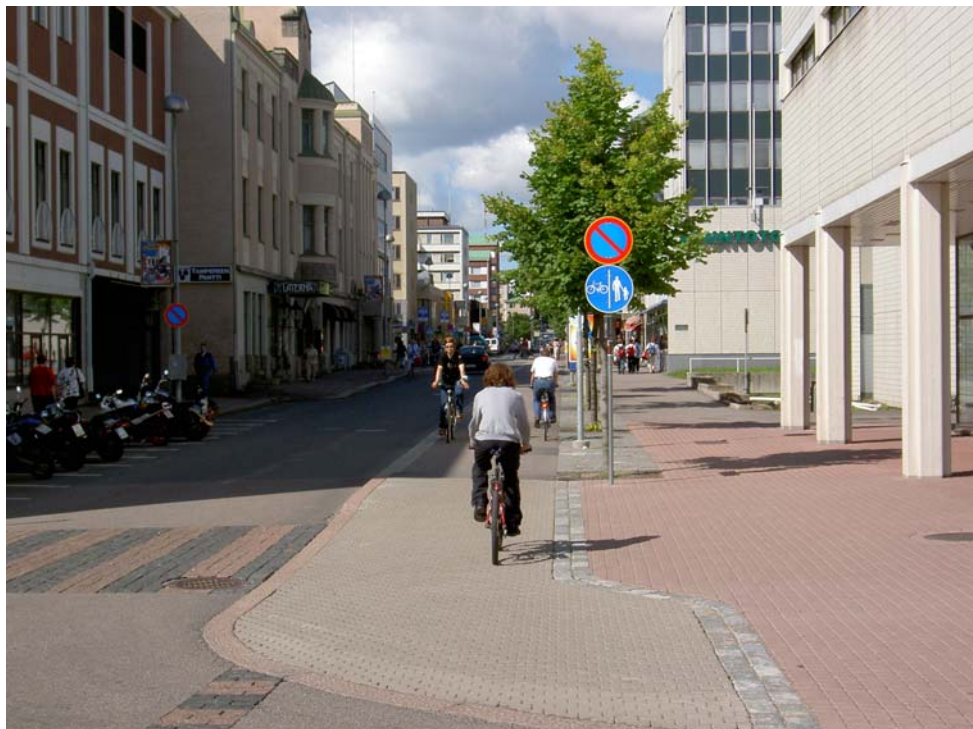
Kuva 11 Puutarhakadulla jalkakäytävän ja pyörätien erottelu on hoidettu toisistaan erotuskaistalla, jonka leveys on 1,5 metriä. Erotuskaistalle on istutettu puita ja sijoitettu mm. mainostauluja.
