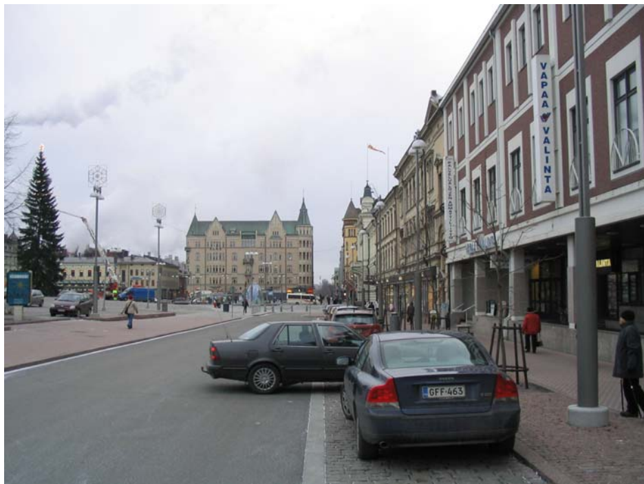
Kuva 14 Aleksis Kiven kadulla pysäköintikaista on erotettu ajoradasta upotetulla reunatuella ja jalkakäytävästä korotetulla erotuskaistalla. Näin pysäköidyille autoille on osoitettu selkeästi oma paikka.
