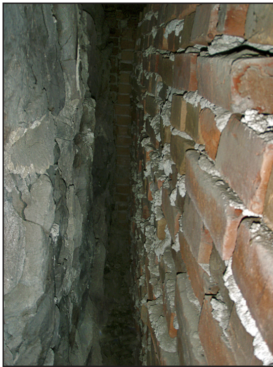
Kuva 9. Vanhaa perus- ja uudempaa tiilimuuria.
