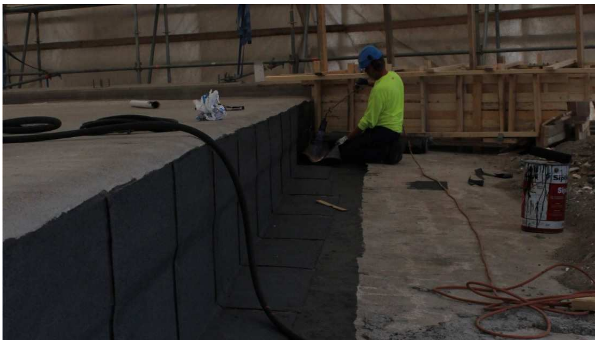
KUVA 20 Kannen päädyn kermieristystyö käynnissä (Laaksonen Matti, 2013-09-11)
