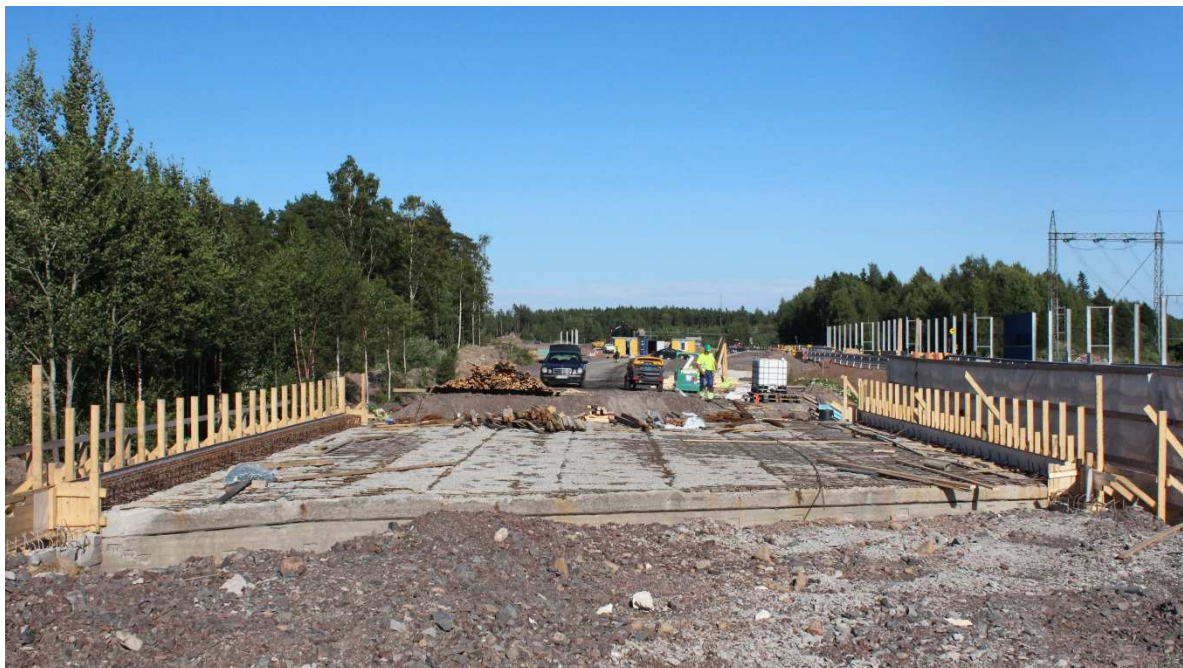
KUVA 18 Kannen reunapalkkien muotit tuplausta odottamassa (Laaksonen Matti, 2013)
