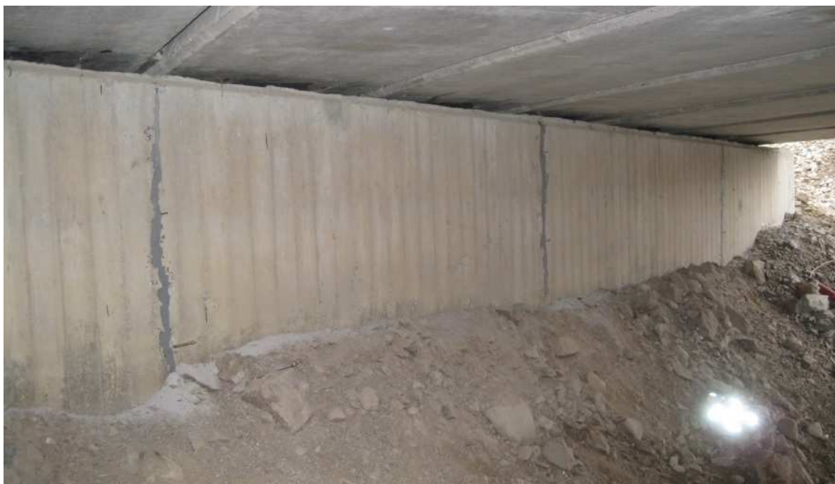
KUVA 9 Kotkanpuoleisen maatuen halkeamat injektoituna (Saresma Mikko, 2013-10-15)
