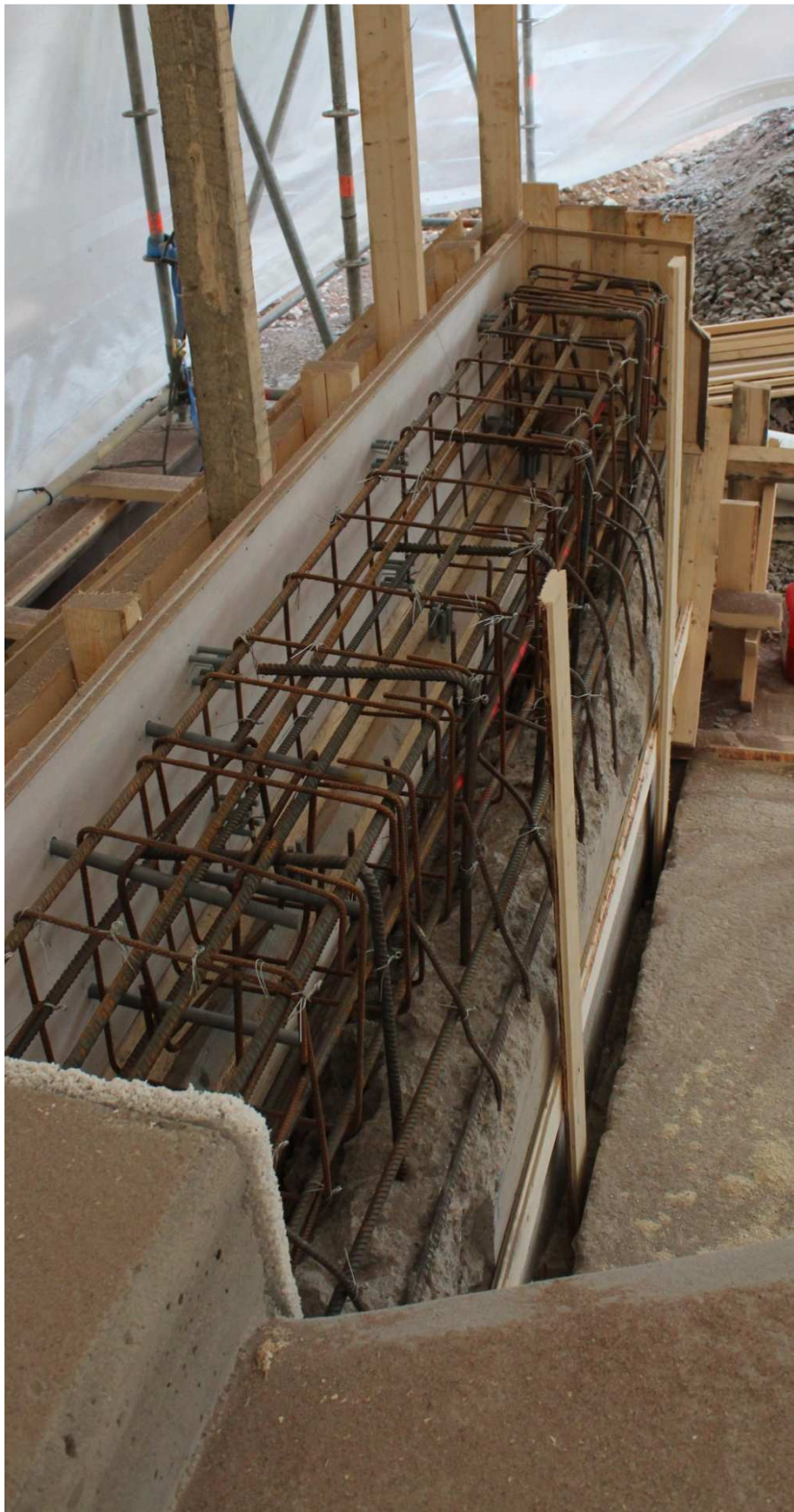
KUVA 19 Valmis siipimuurin raudoitus (Laaksonen Matti, 2013)
