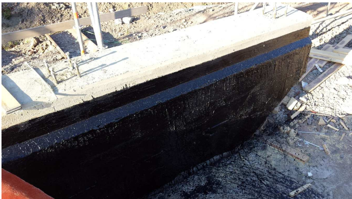
KUVA 21 Kumibitumisivelty siipimuuri (Laaksonen Matti, 2013)
