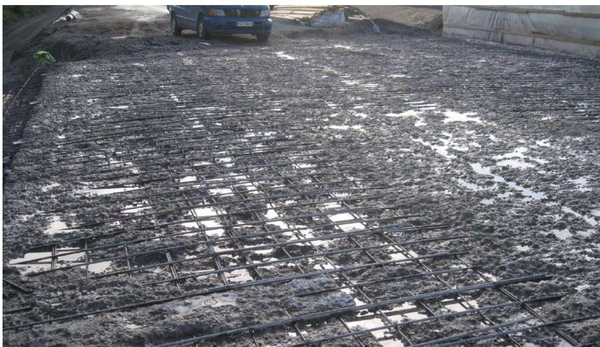
KUVA 5 Kansi vesipiikkauksen ja puhdistuksen jälkeen (Saresma Mikko, 2013)
