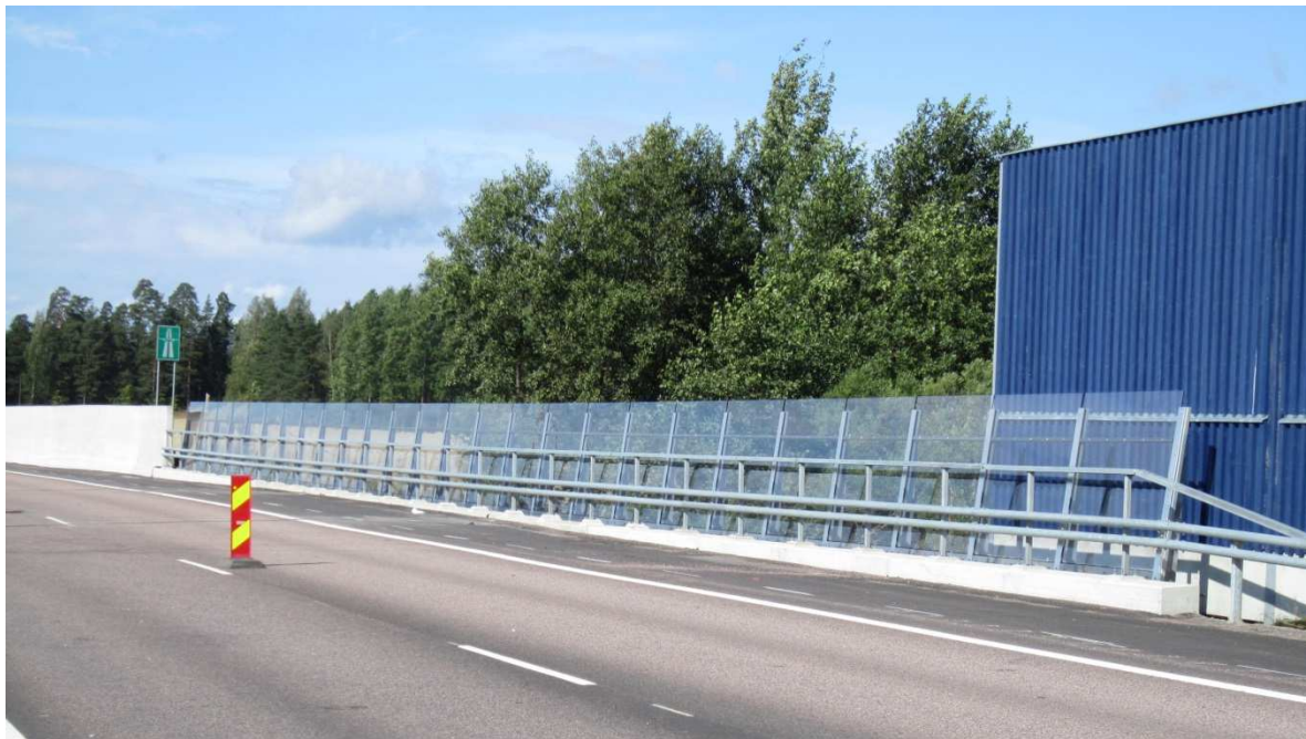
KUVA 27 Lähteen sillan kaiteet asennettuna (Laamanen Jussi, 2014-08-20)
