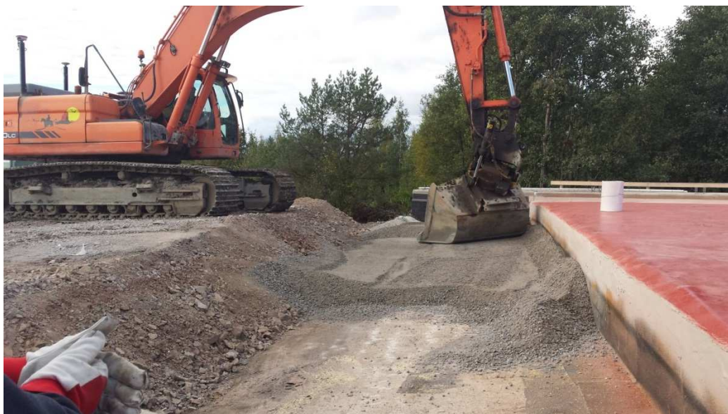
KUVA 24 Kannen päädyn täyttötöyt käynnissä (Laaksonen Matti, 2013)
