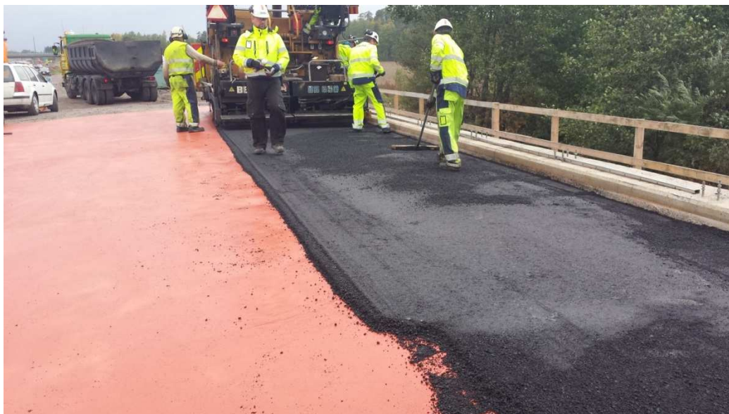
KUVA 25 Kannen suoja-asfaltointi käynnissä (Laaksonen Matti, 2013)
