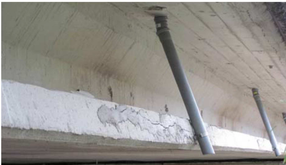
KUVA 13 Jatketut tippuputket (Ramboll Oy, 2012)
