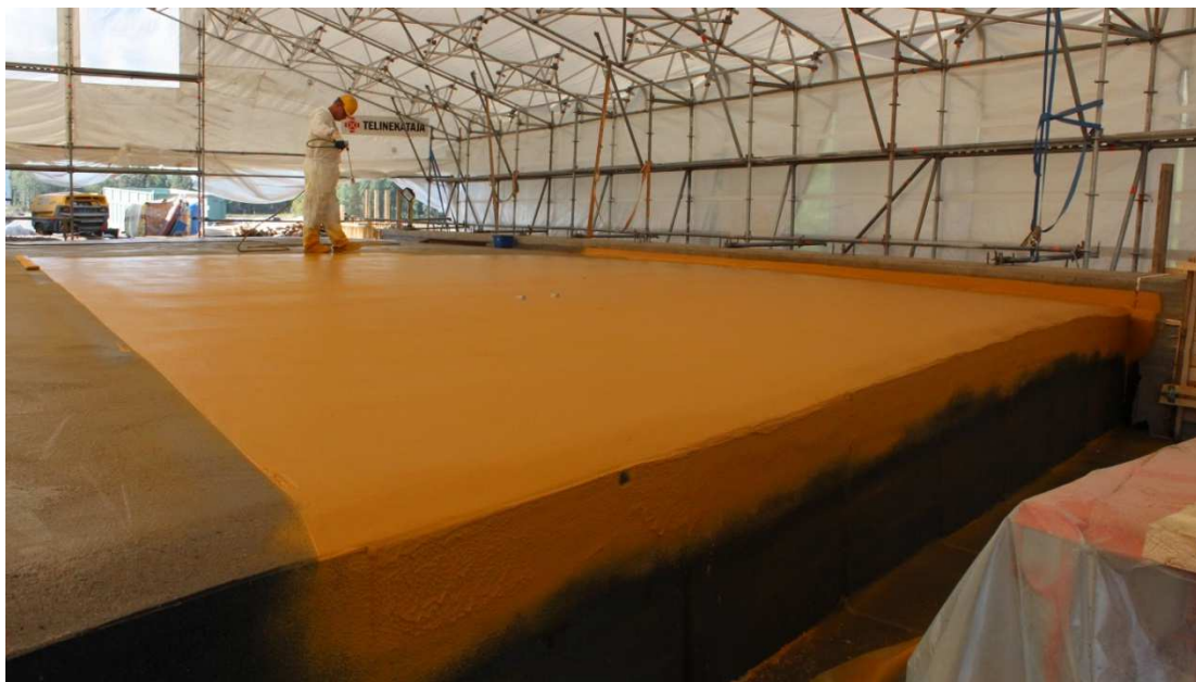
KUVA 22 Kannen vedeneristystyö käynnissä (Laaksonen Matti, 2013-09-13)
