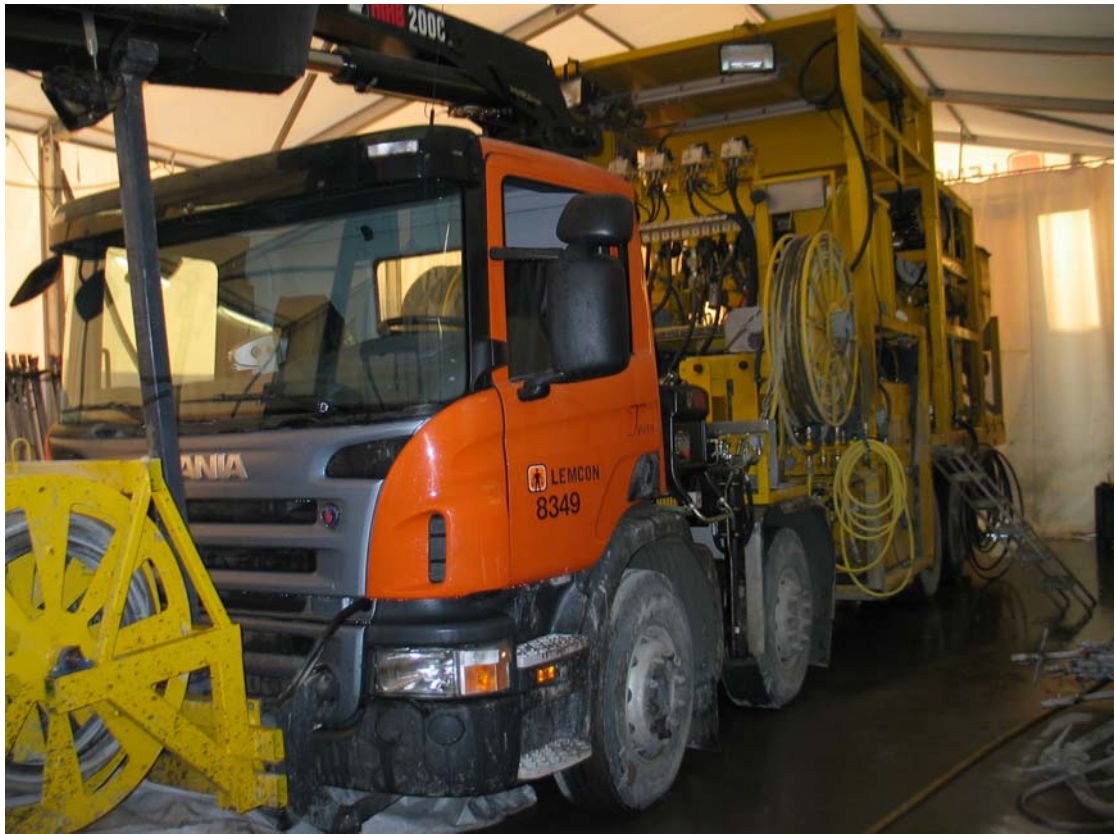
Kuva 11 Nygård-tunnelissa käytettävä injektointiajoneuvo
