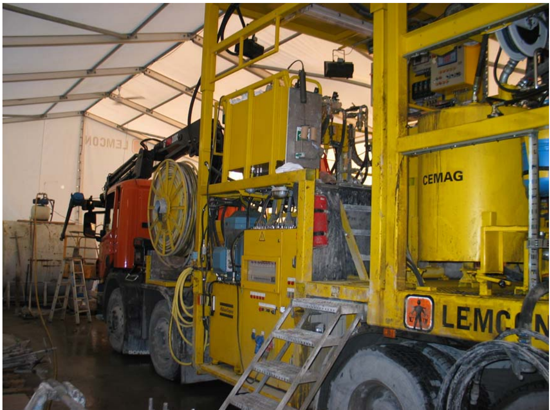
Kuva 12 Nygård-tunnelissa käytettävä injektointiajoneuvo
