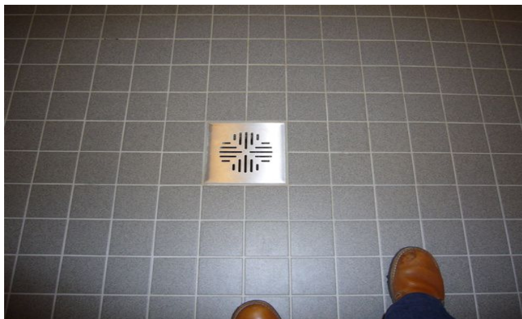
Kuva 8 Korjattu kylpyhuoneen lattia
