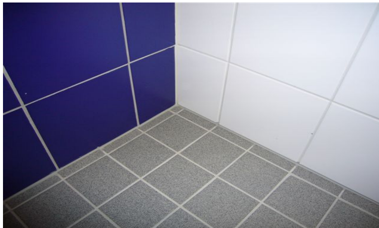
Kuva 10 Remontoidun kylpyhuoneen kulma
