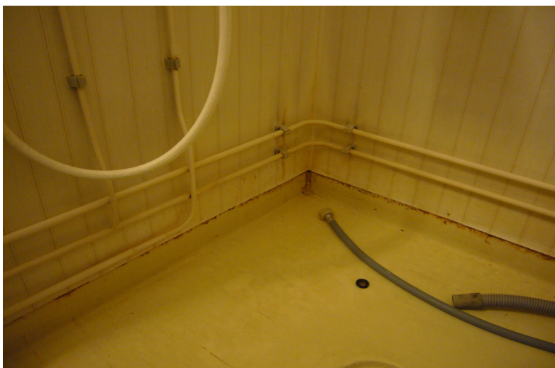
Kuva 2 Lattia- ja seinäpinnoitteen liitoskohta
