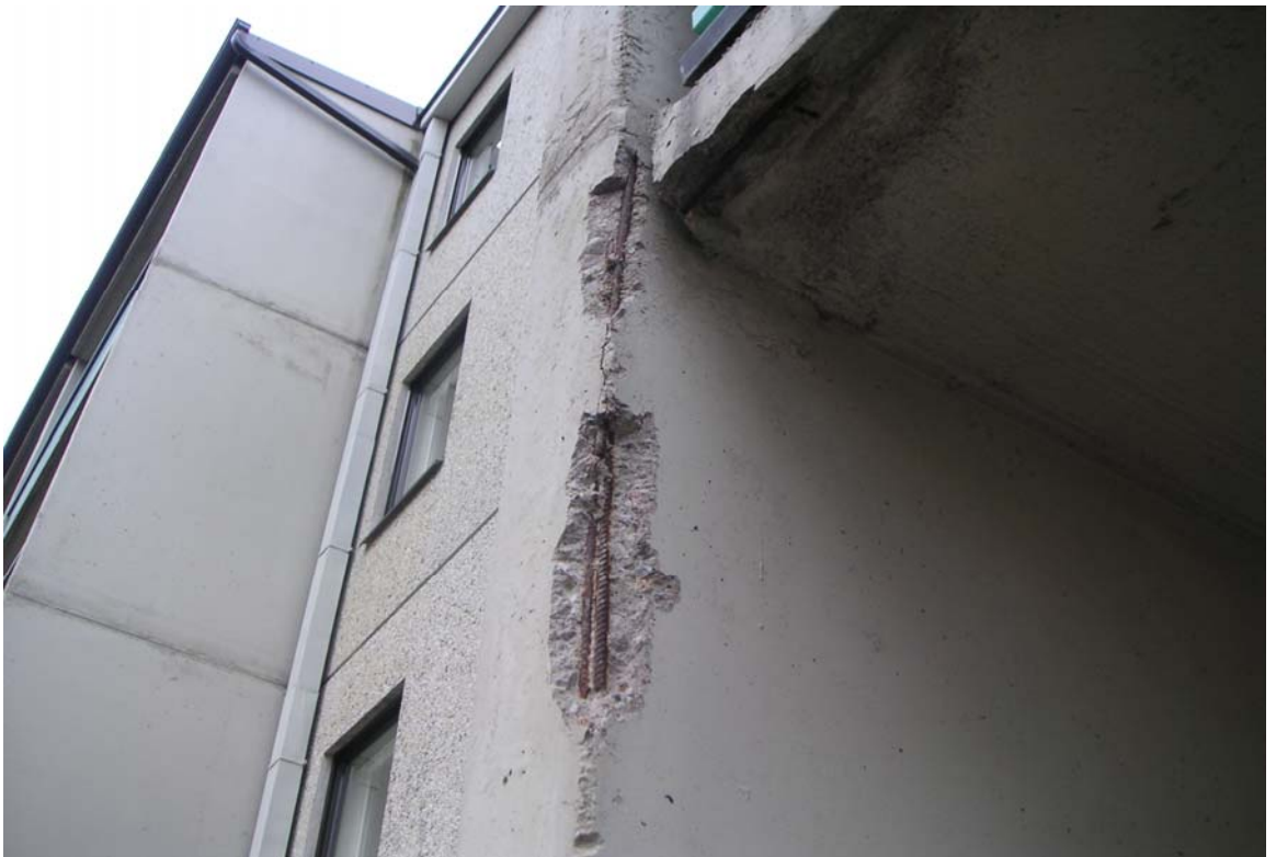
Kuva 10. Pieliseinän etureunassa esiintyy korroosion aiheuttamaa betonin lohkeilua.
