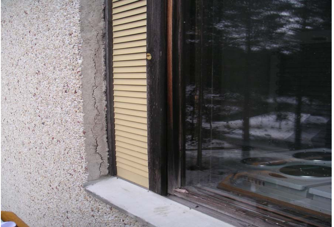
Kuva 5. Ikkuna-aukon pielessä on teräksen korroosiosta johtuva halkeama.
