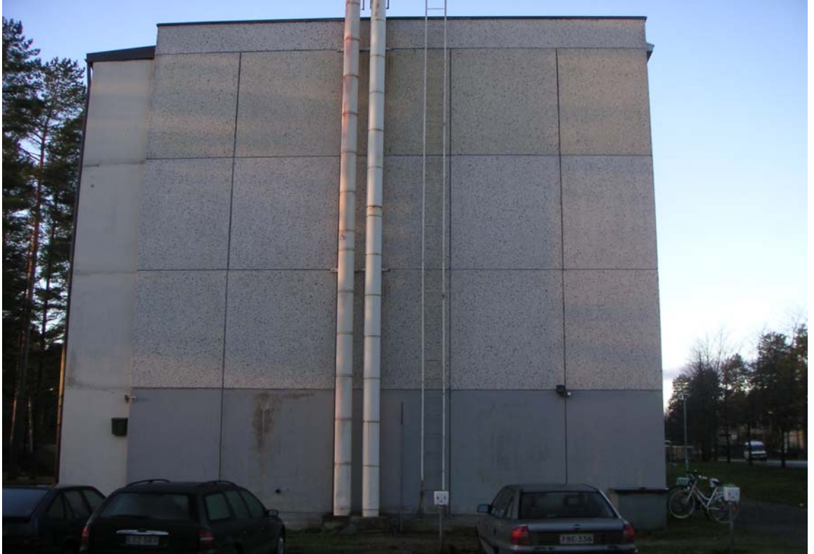
Kuva 7. Talon itäpäädyssä esiintyy pohjakerroksen elementin ja pesubetonielementin välillä hammastusta.
