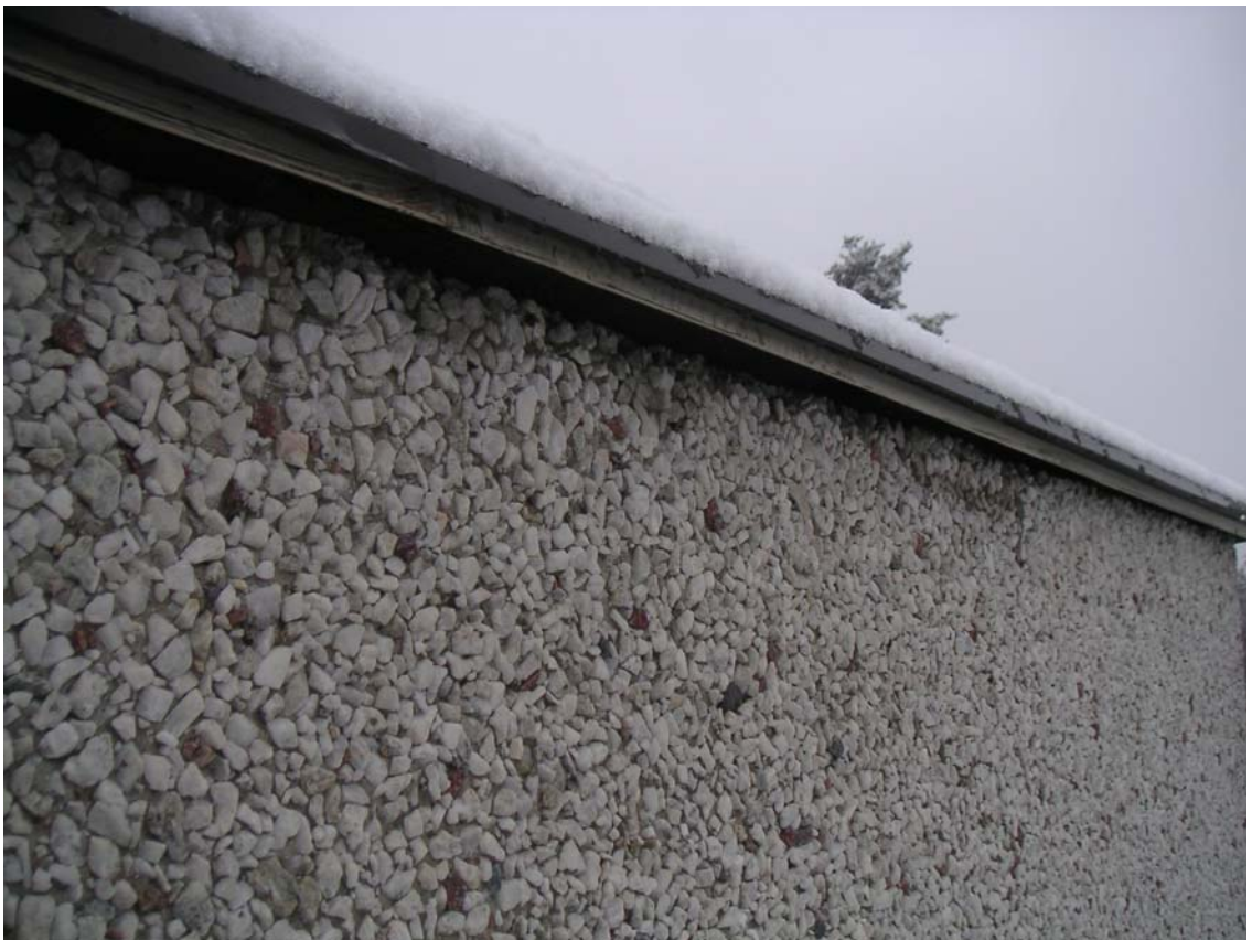
Kuva 20. Päädyssä räystäspellin limitys on puutteellinen.
