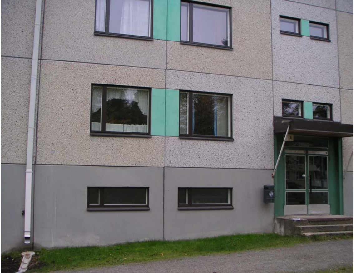
Kuva 1. Elementtien hammastusta A- ja B-rapun välissä kohdal- ta, jossa havaittiin perustusten painumaa.
