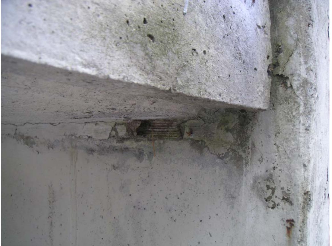
Kuva 15. Parvekelaatan vanerinen asennuslappu on näkyvissä.
