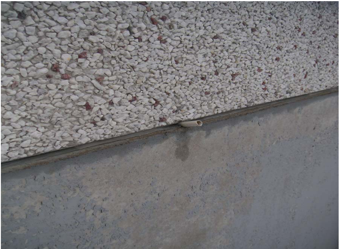
Kuva 8. Lähikuva edellisestä, pohjakerroksen elementin ulko-kuori on ulompana.
