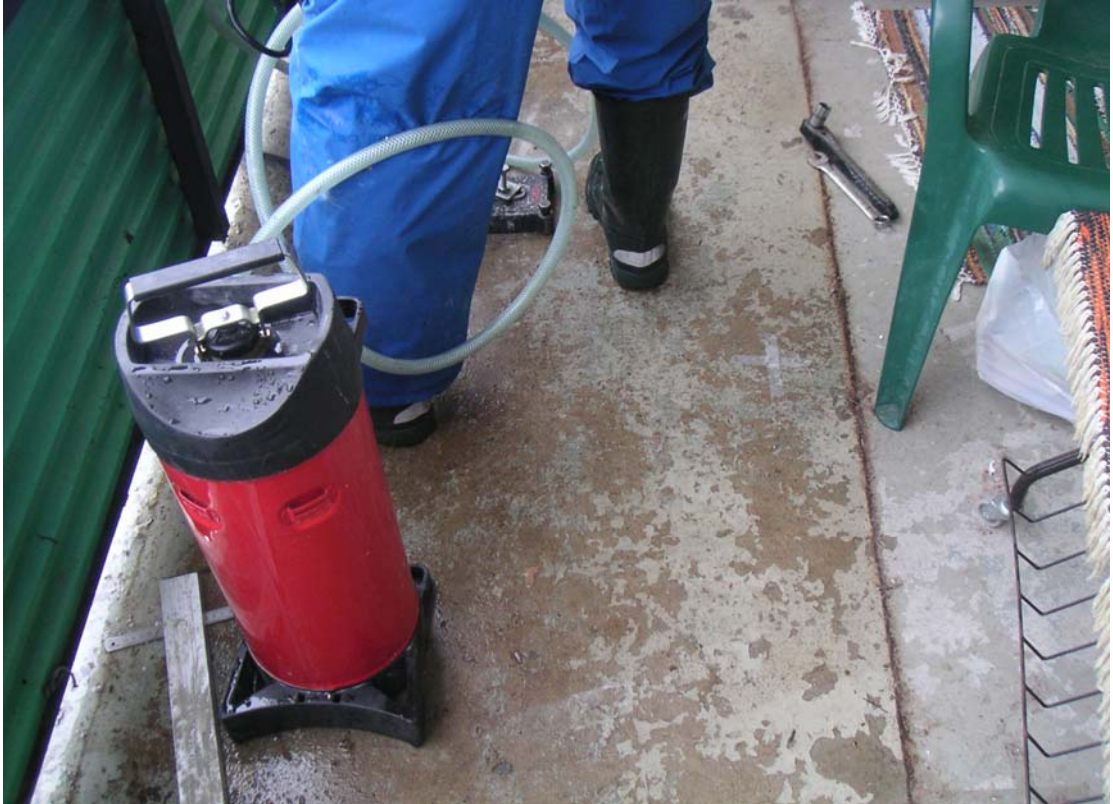
Kuva 17. Parvekelattian maalipinnoite on irtoillut.
