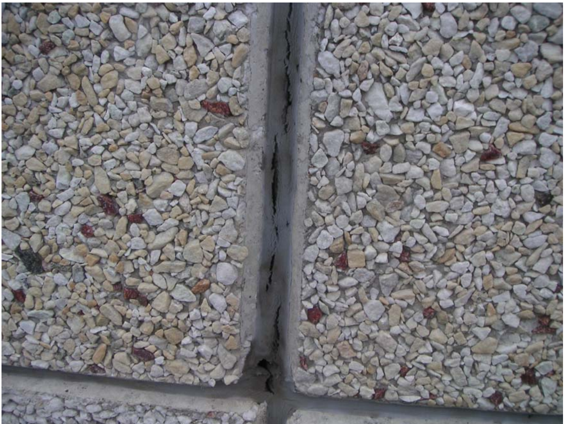
Kuva 6. Elementtisauma on halkeillut/repeytynyt ja tuuletusputki on irronnut.
