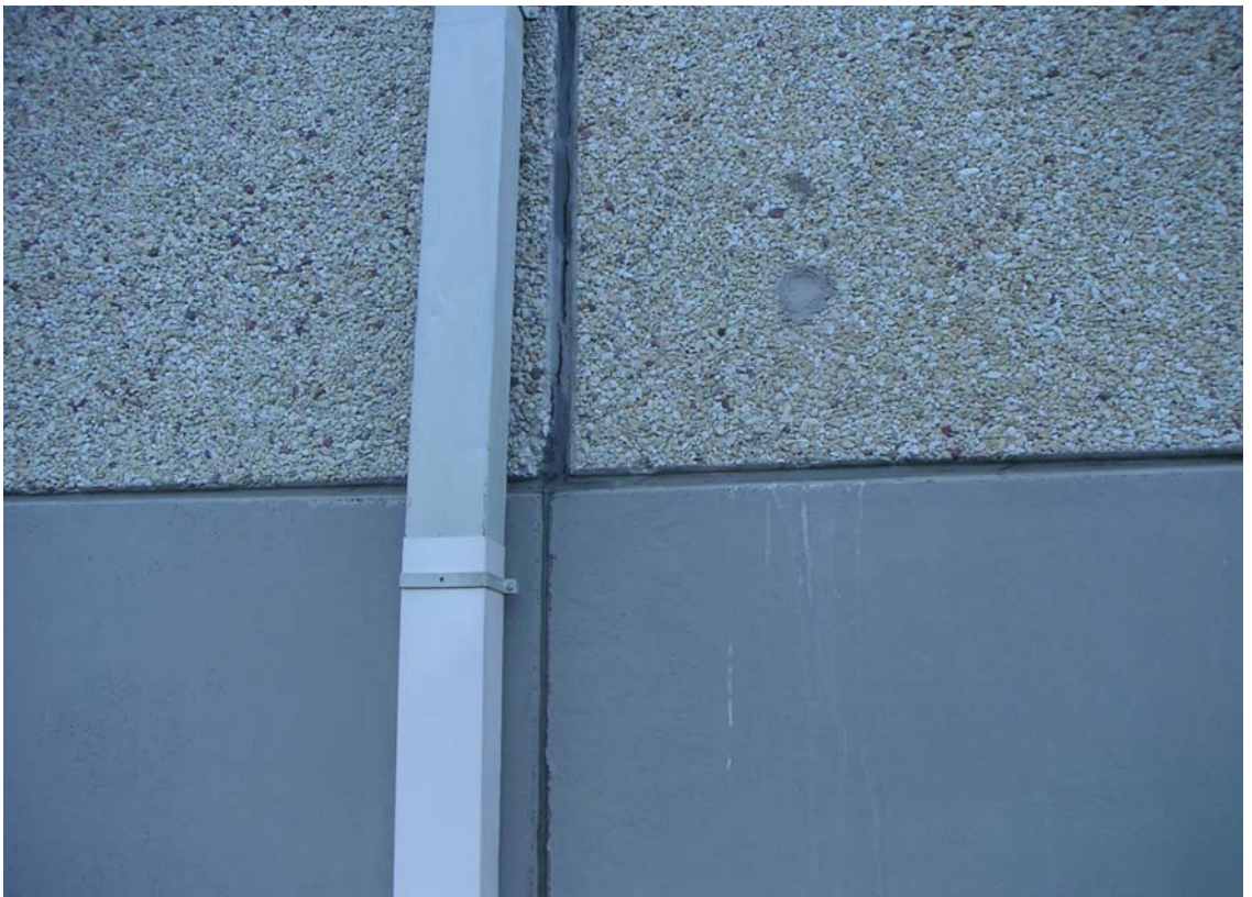
Kuva 2. Elementtien hammastusta edellä mainitusta kohdasta.
