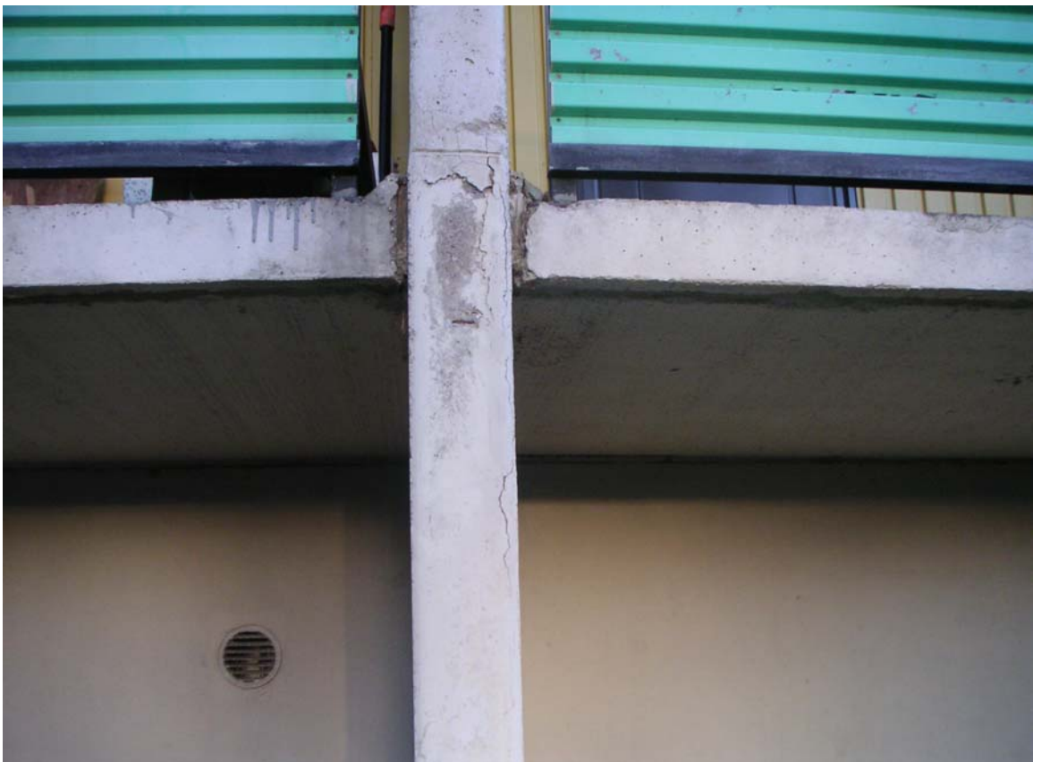
Kuva 12. Halkeilua peiliseinän etupinnassa.
