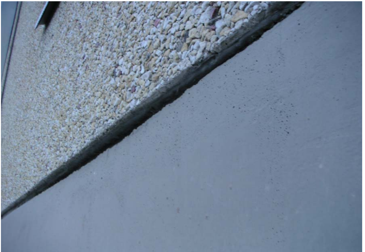
Kuva 4. Pohjakerroksen elementin käyristymää em. kohdassa.
