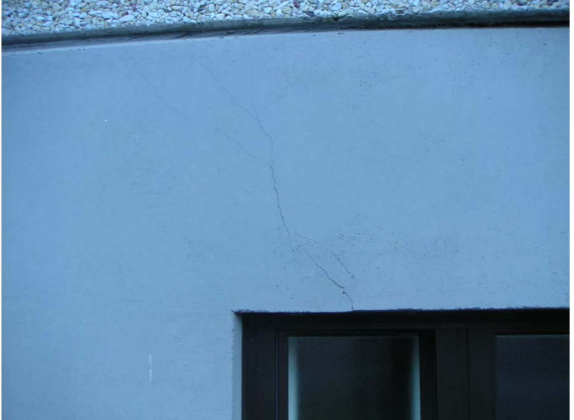
Kuva 3. Halkeama ikkunan yläpuolella em. kohdassa.
