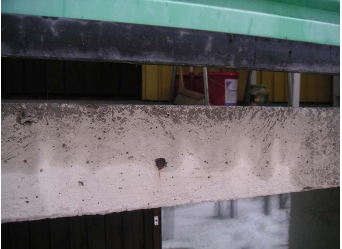
Kuva 13. Parvekelaatan otsapinnassa on ruostunut teräksen pää.
