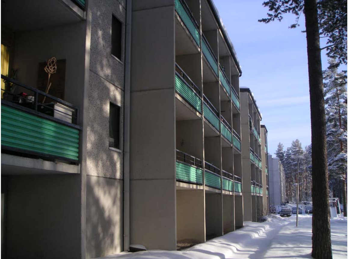
Kuva 9. Yleiskuva parvekkeista, kuvasta näkyy parvekelaattojen pituussuuntaista taipumaa.
