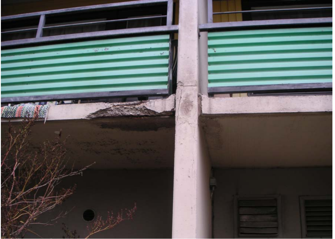
Kuva 11. Parvekelaatan etuosassa korroosion aiheuttamaa lohkeilua.
