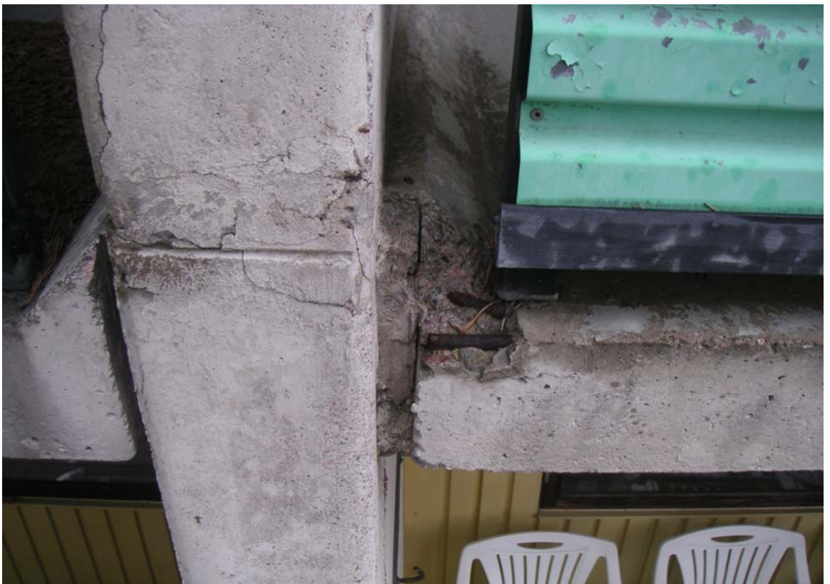
Kuva 14. Pieliseinän ja parvekelaatan liitoskohta.
