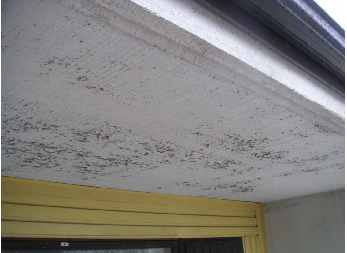
Kuva 19. Maalipinnoite on hilseillyt parvekekatosta.
