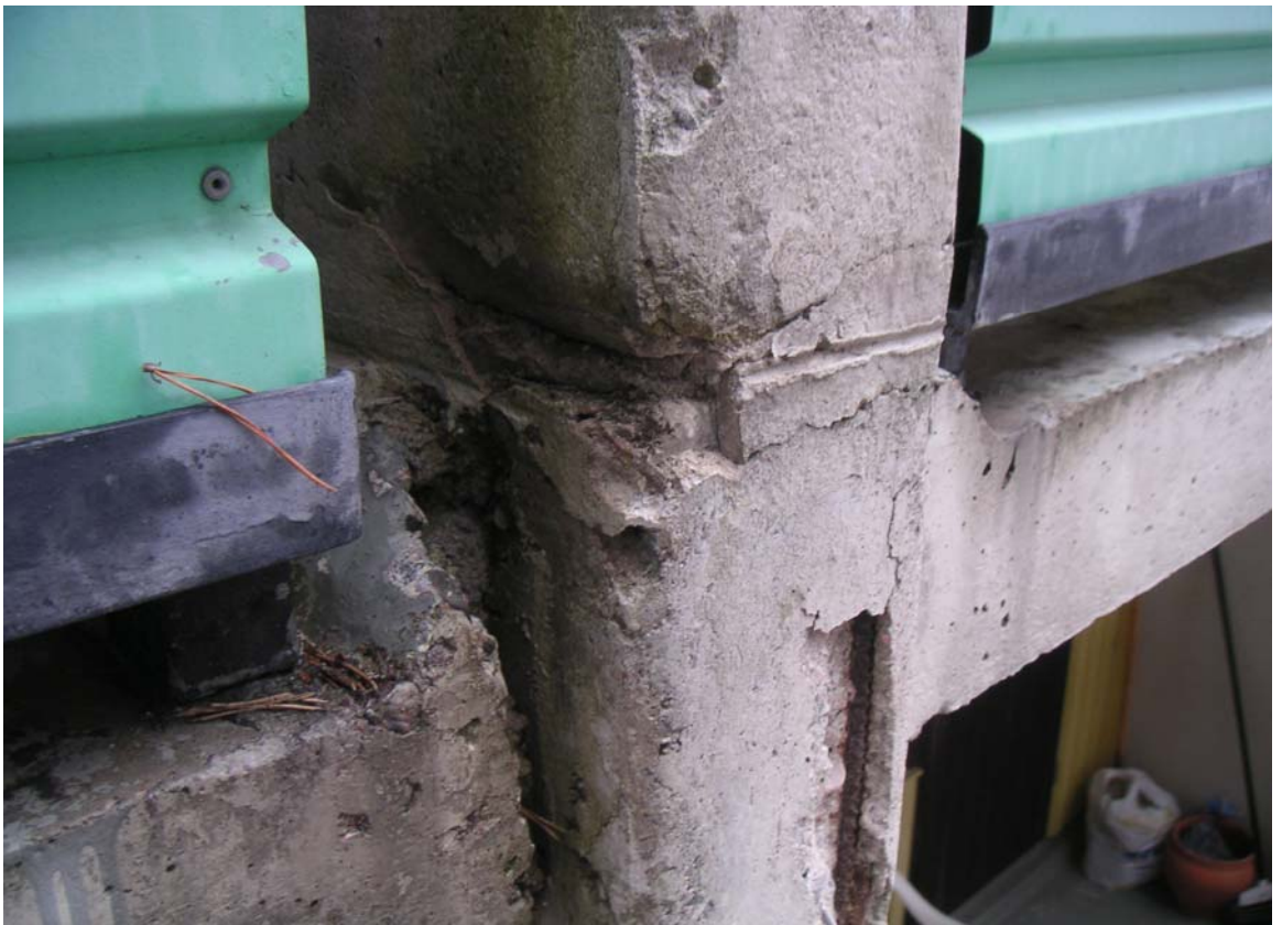
Kuva 16. Parvekelaatan ja pieliseinän liitoskohta.
