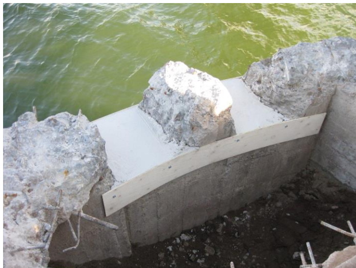
Kuva 13. Tuen tasot valettuna.
