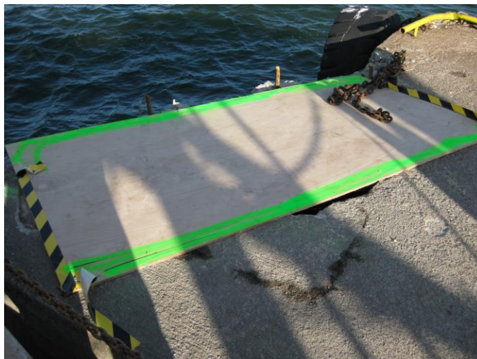
Kuva 4. Aukko peitettynä vanerilla.
