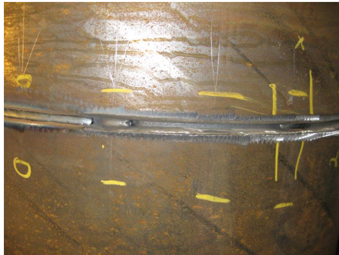
Kuva 11. Putken sauman hitsaus alkuvaiheessa.
