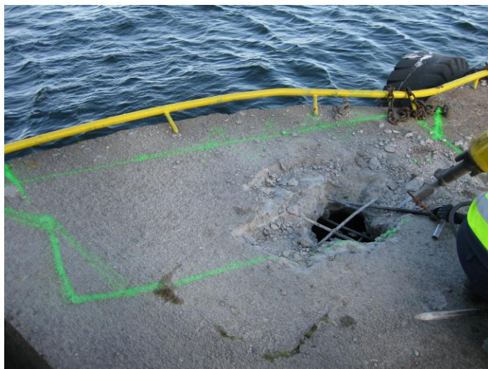
Kuva 3. Tihtaalin purku aivan alkuvaiheissa.
