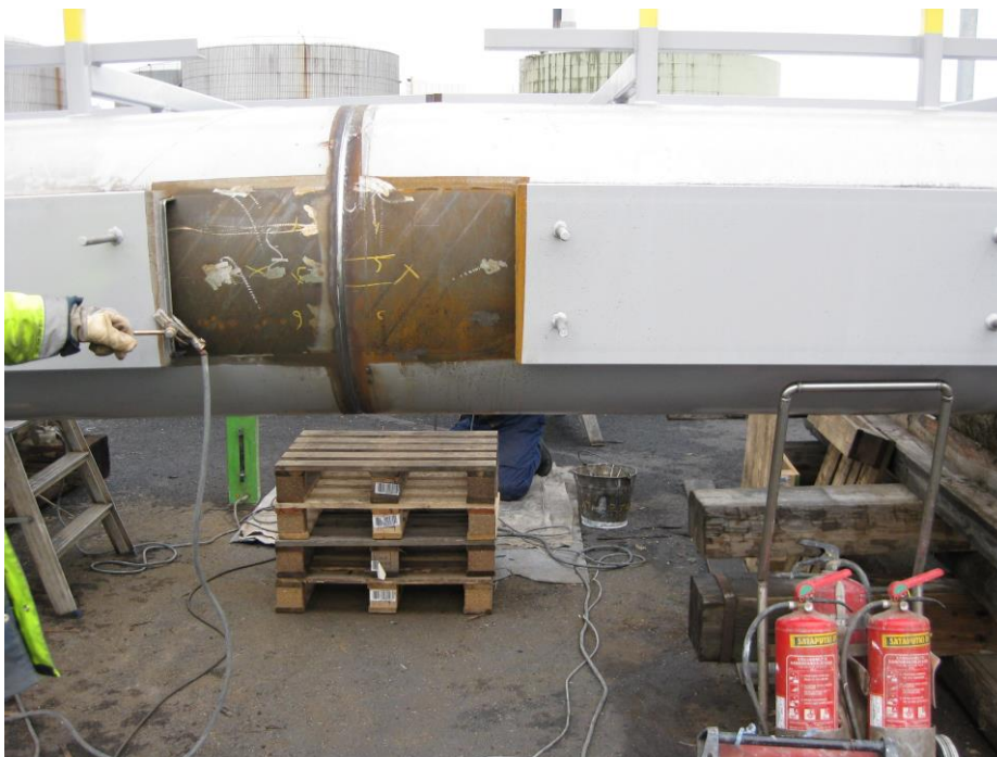
Kuva 18. Valmis putken hitsisauma.
