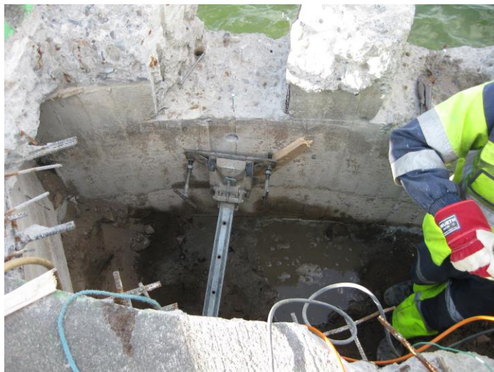
Kuva 12. Tihtaaliin porattiin sillan tukien kiinnitys reikiä.
