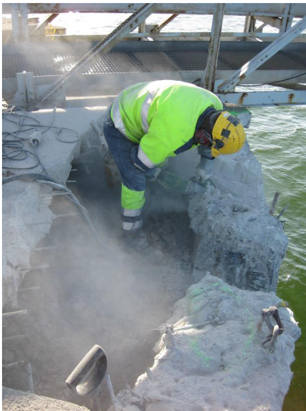
Kuva 5. Tukien aukkojen tekeminen työn alla.
