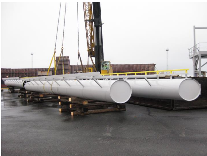
Kuva 17. Sillan puolikkaiden nosto pedeille.
