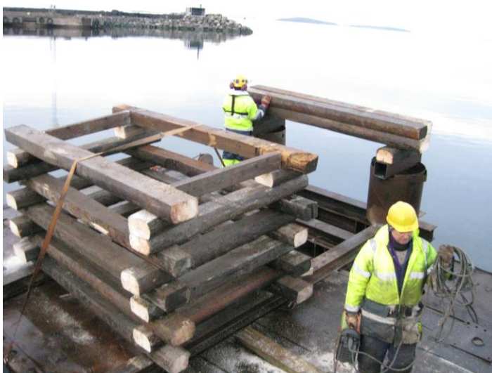
Kuva 20. Ponttonin päälle koottu tukipeti.
