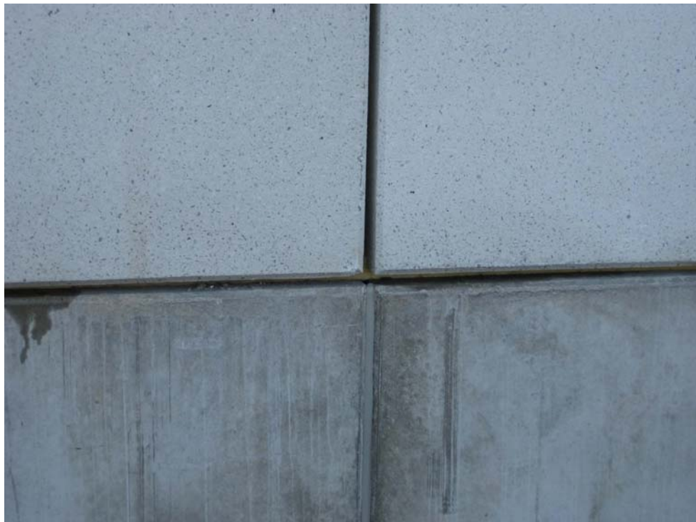
Kuva 24. Rakenteilla olevan talon saumaamattomat elementtisaumat
