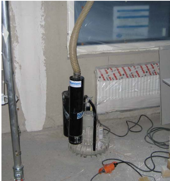
Kuva 25. Korkeapainepuhallin onteloiden kuivatuksessa
