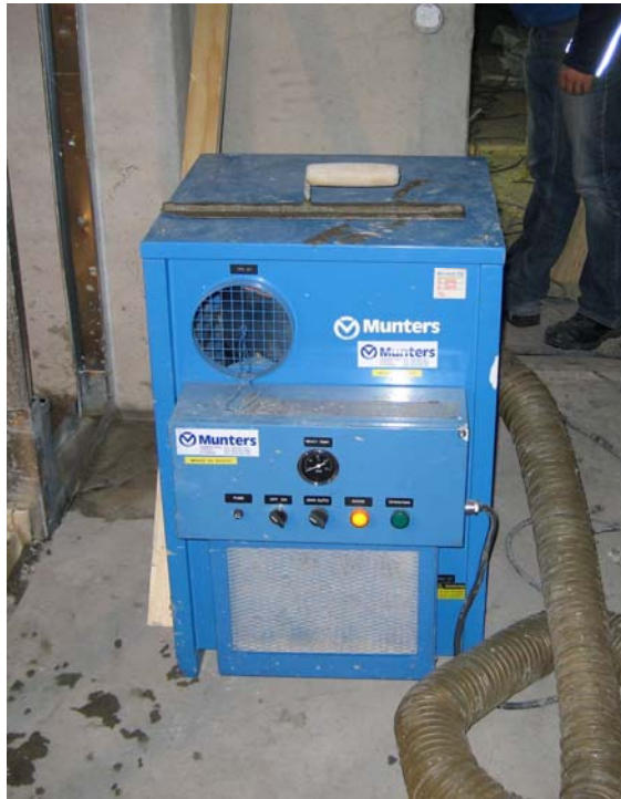
Kuva 4. Ilmankuivaaja rakennustyömaalla
