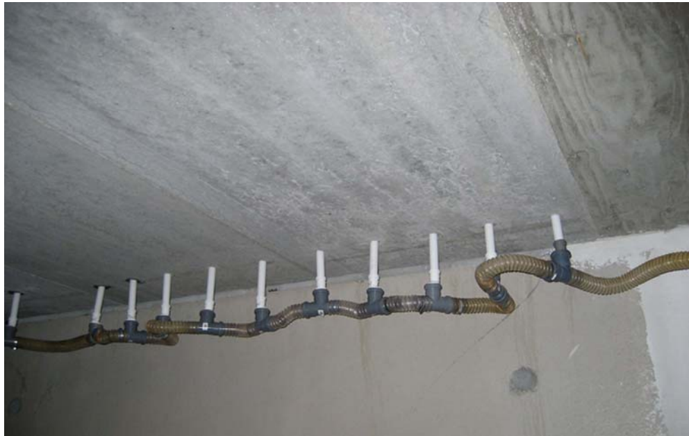
Kuva 23. Onteloiden kuivaus käynnissä
