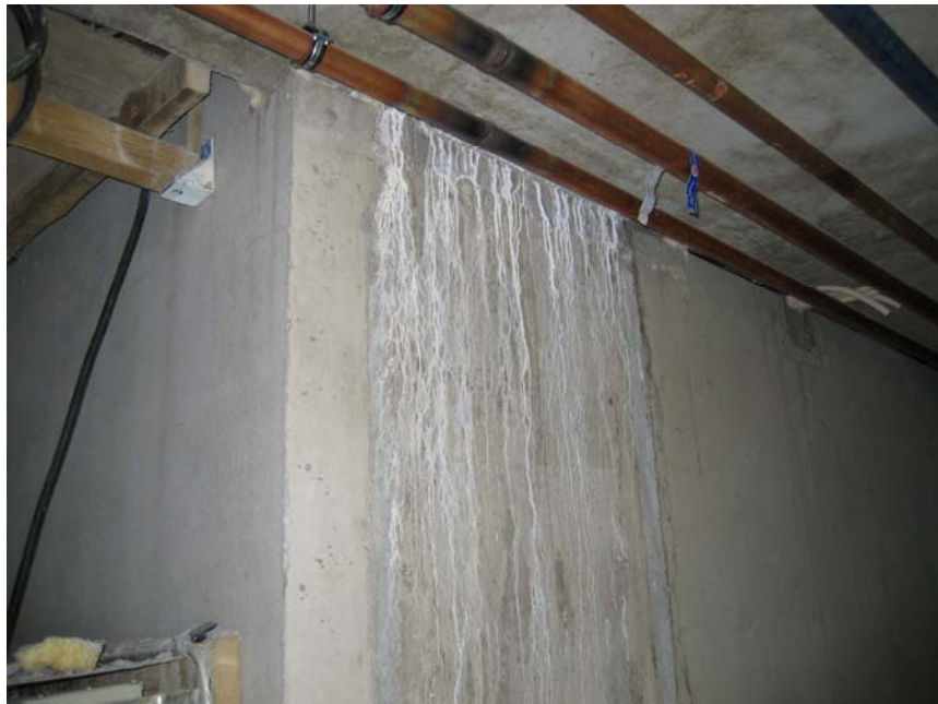
Kuva 7. Jälkiä holvilta alempiin kerroksiin valuneesta vedestä
