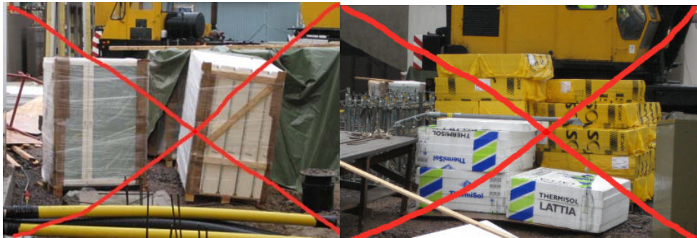
Kuva 5. Esimerkkejä puutteellisesta rakennusmateriaalien varastoinnista
