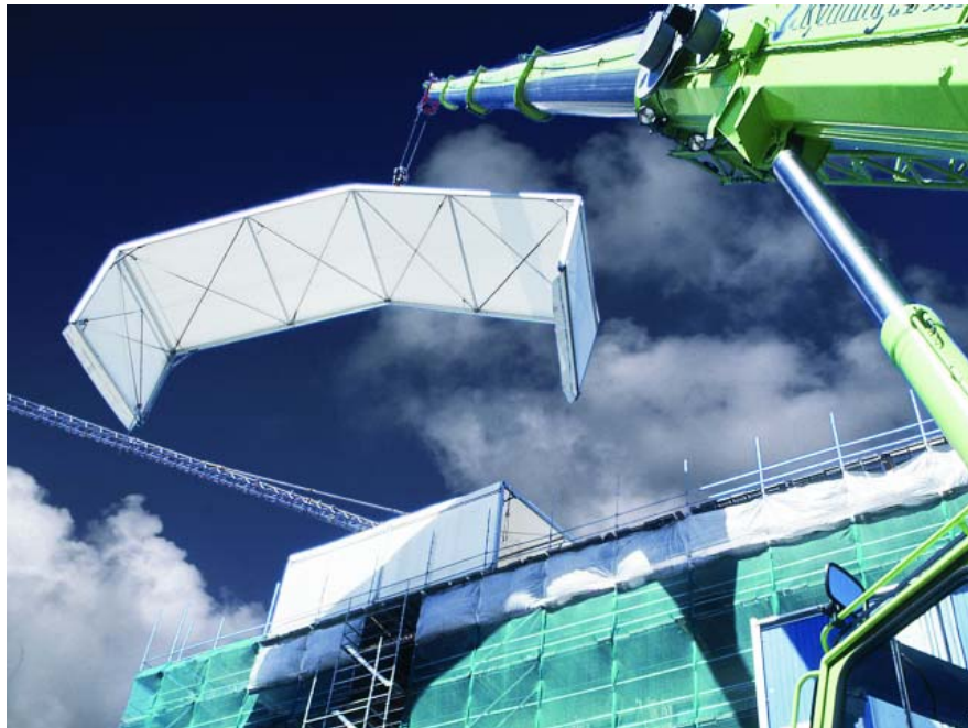
Kuva 3. Sääsuojan asennus käynnissä /16/
