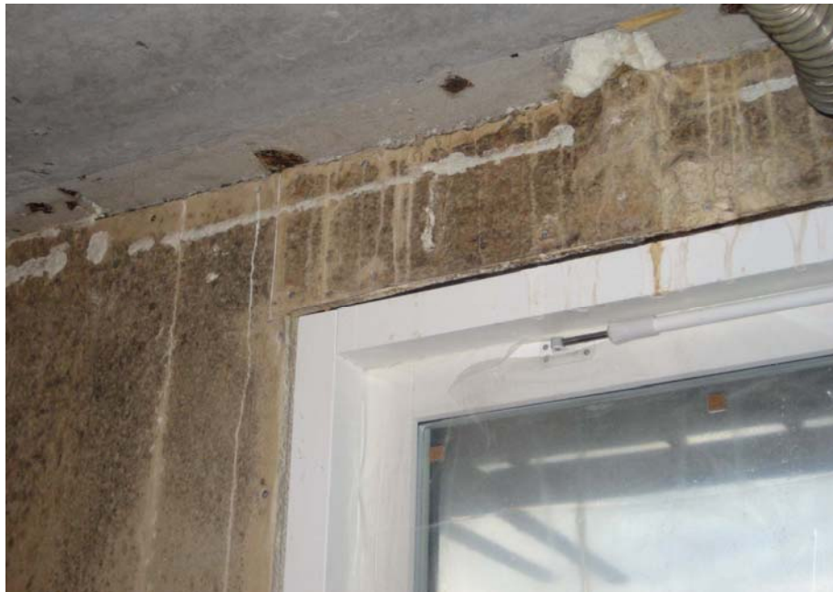
Kuva 6. Kastunut puuelementtiseinä
