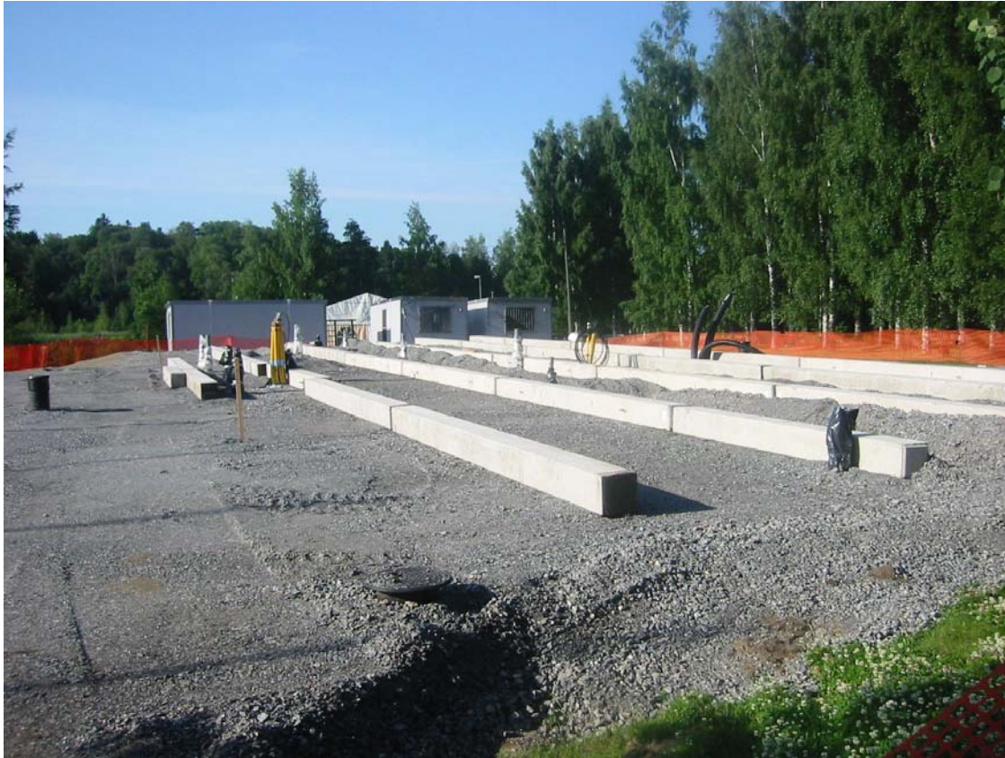
Kuva 1. Tasauskerroksen päälle tehtävät perustukset.
