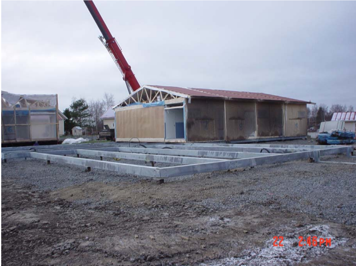
Kuva 2. Rautaruukin RR- teräspöerustus sekä 4 tilaelementtiä paikoillaan.
