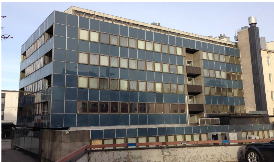
Kuva 1. Esimerkkikohde Kiinteistö Oy Riihimäen Kassatalo.
