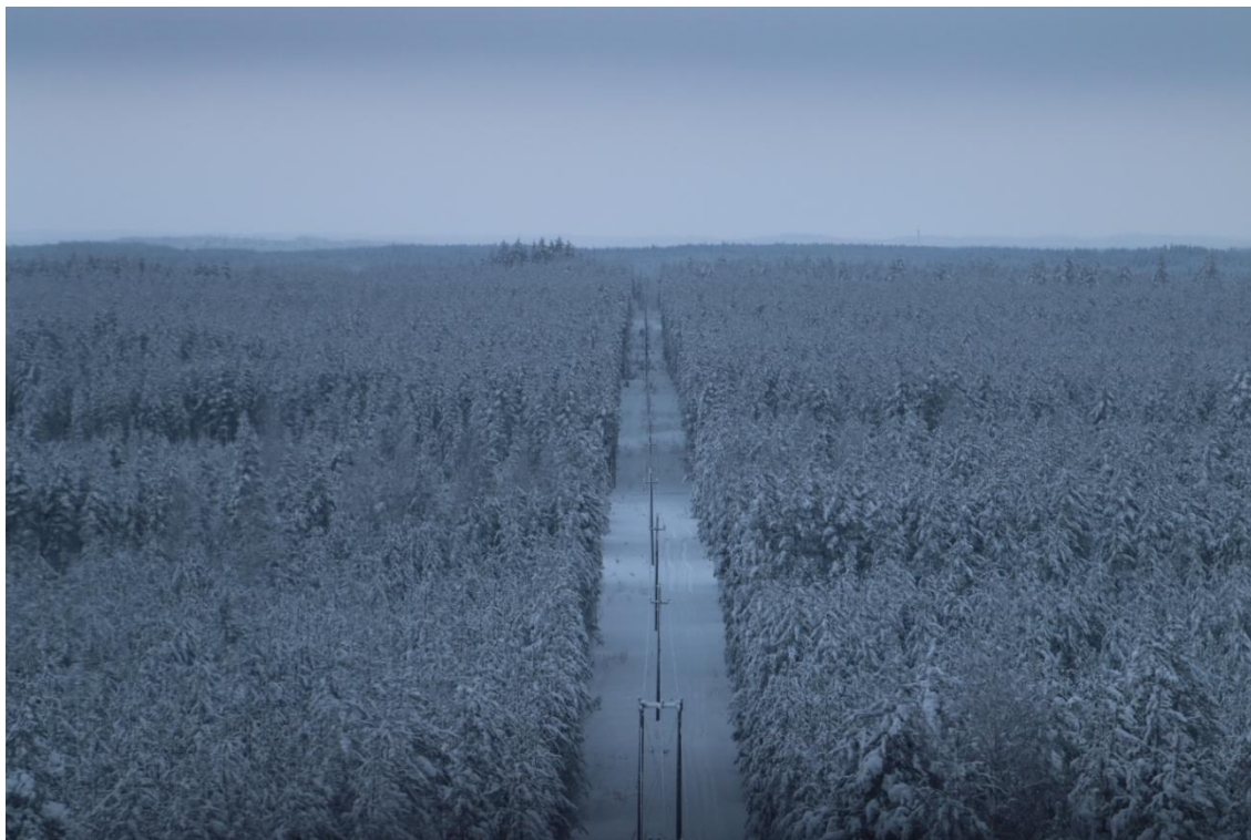
Kuva 9. Helikopteriraivattu 20 kV johtokatu.
