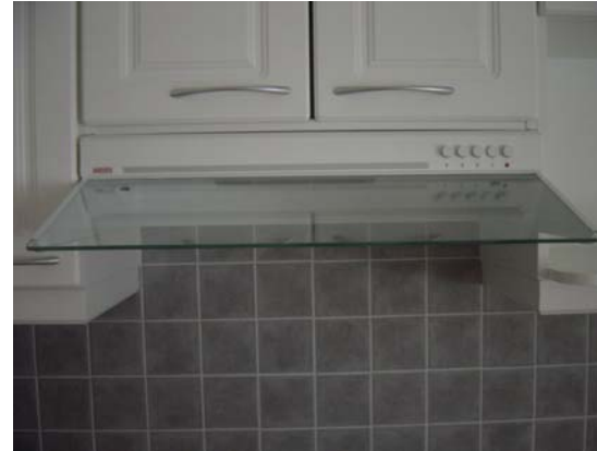
Liesikuvusta ohjataan asuntokohtaista ilmanvaihtokonetta (LTO), joka sijaitsee KHH:ssa.
