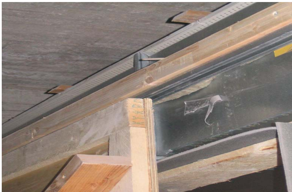
Kuva 8. Liukuovi kiskon kiinnitys suojaseinään
