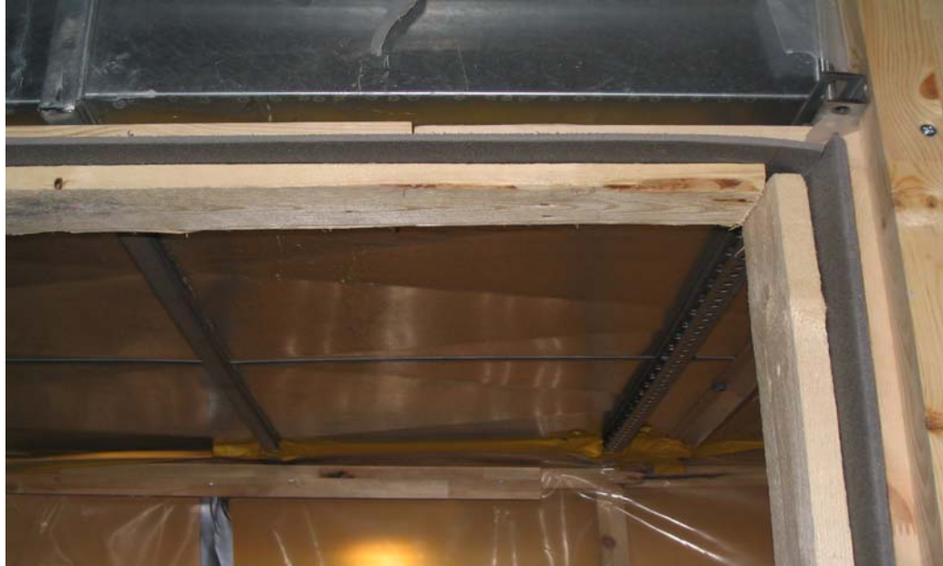
Kuva 7. Solumuovikaistale toimii tiivisteenä karmin ja liukuoven välissä
