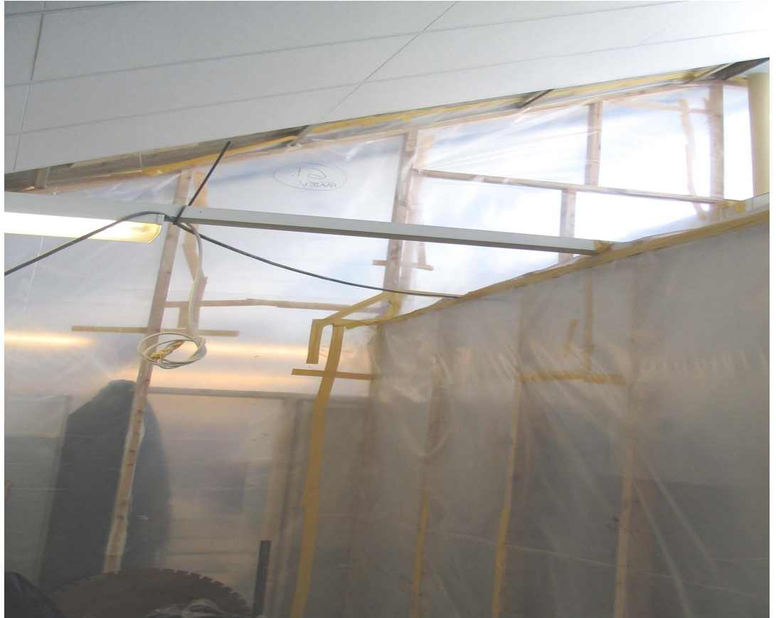
Kuva 3. Muovinen suojaseinä 50 x 50 rungolla
