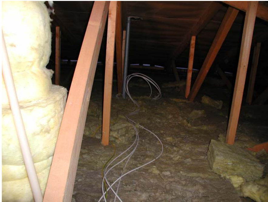
Kuva 3 Kuvan taka-alalla näkyvät tuuletusraot tuuletusraot ovat avonaiset ja niitä näyttäisi olevan riittävästi.
