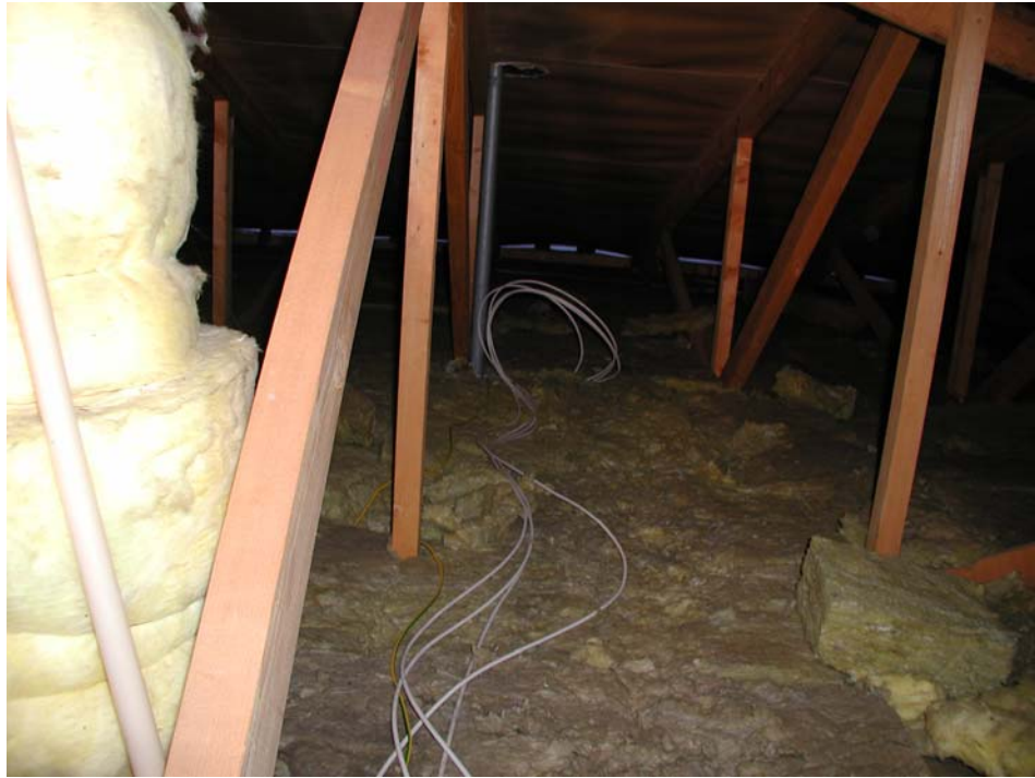
Kuva 8 Kuvassa taka-alalla näkyvät tuuletusraot ovat avonaiset ja niitä näyttäisi olevan riittävästi.
