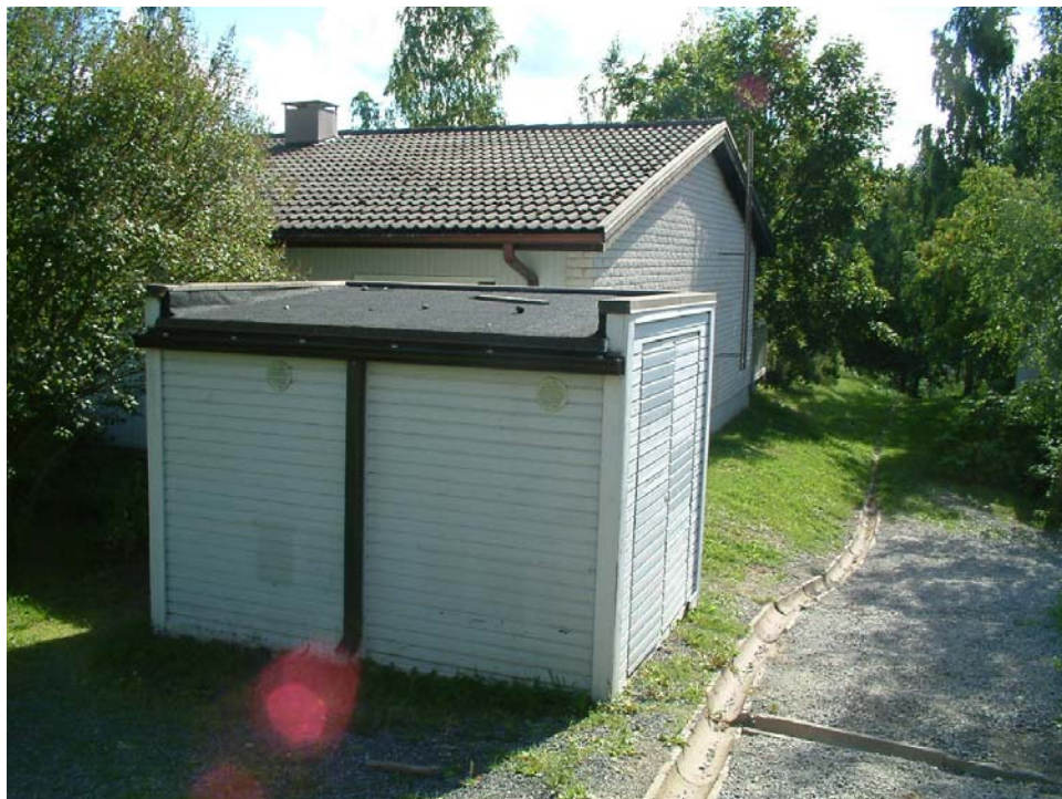
Kuva 12 Kylmä ulkovarasto, jonka puinen ulkoverhous koskettaa maata.
