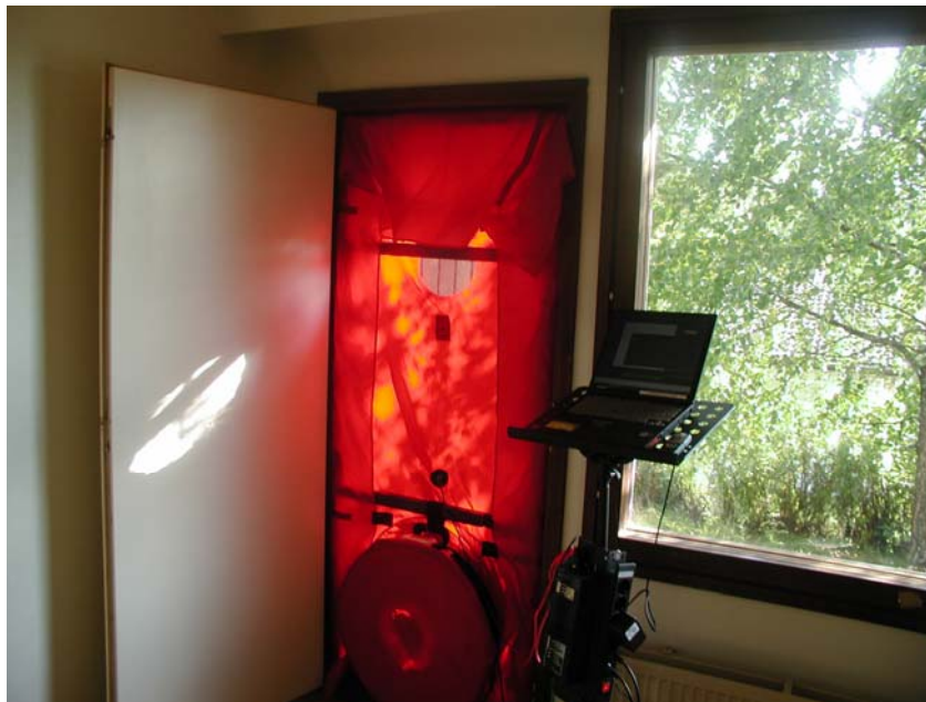
Kuva 1 Rakennuksen tiiveyden mittauslaitteisto
