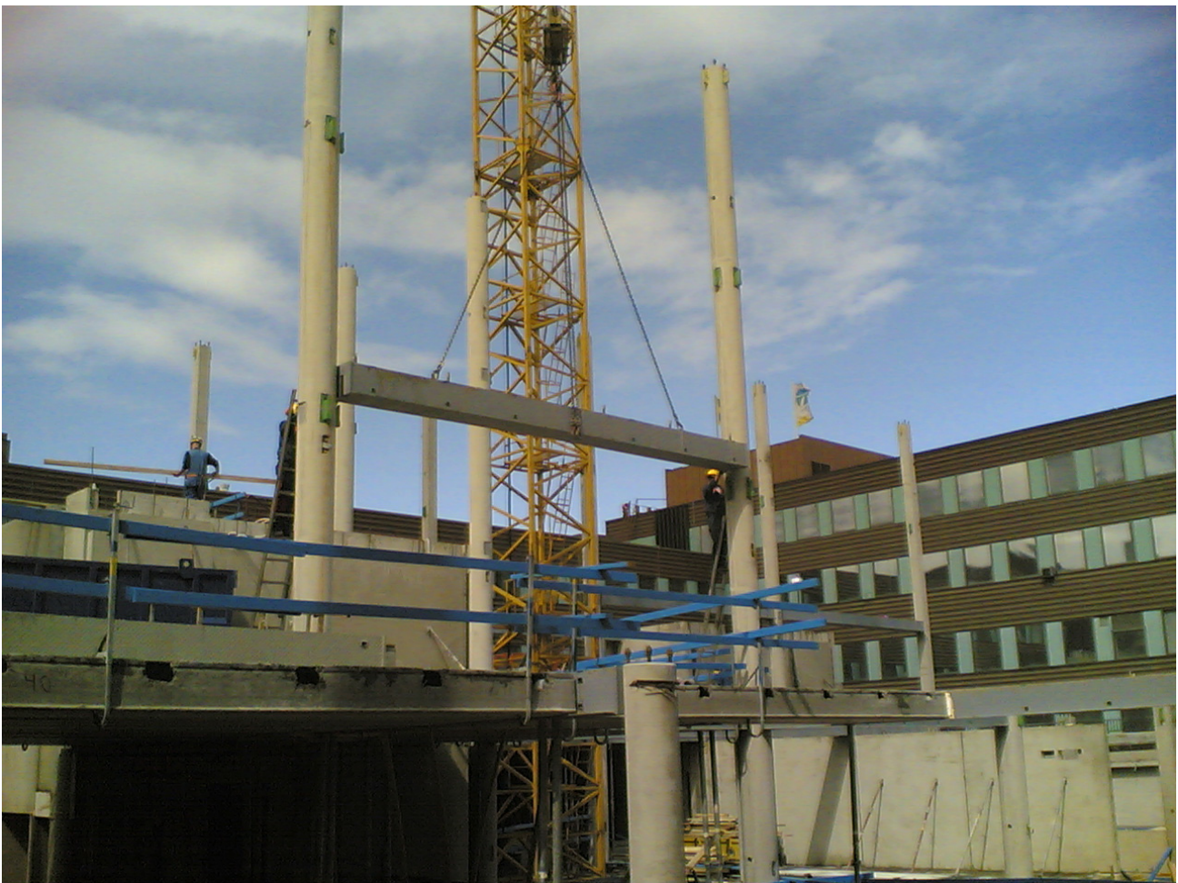
Kuva 6. Palkkiasennus Tampereen yliopiston V-rakennusvaihe
