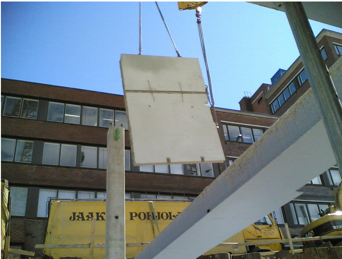
Kuva 7. Kääntökiven kääntö kahdella nosturilla Tampereen yliopiston V-rakennusvaihe
