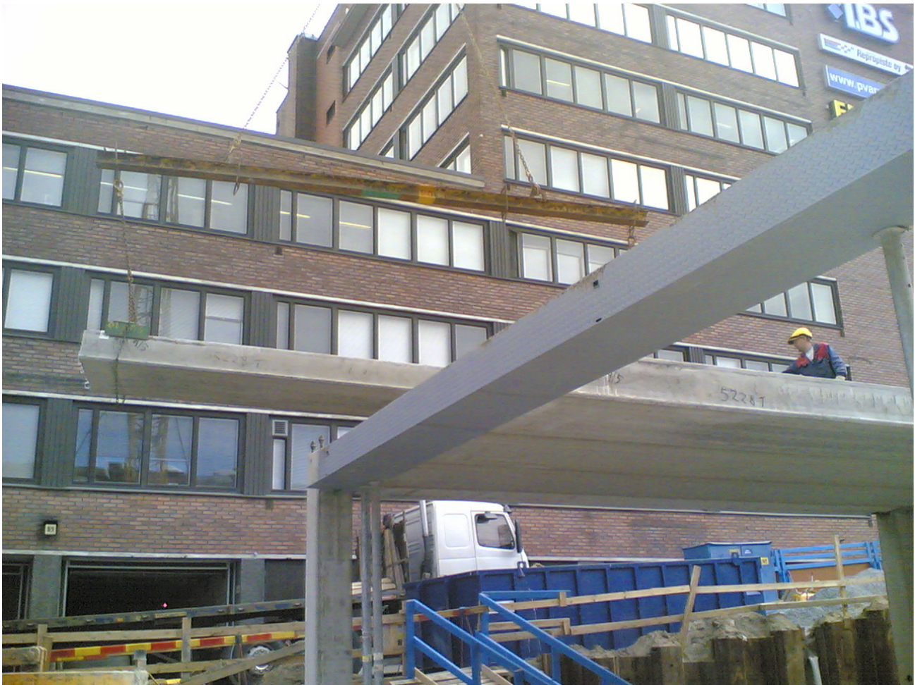
Kuva 5. Ontelolaatta-asennus Tampereen yliopiston V-rakennusvaihe
