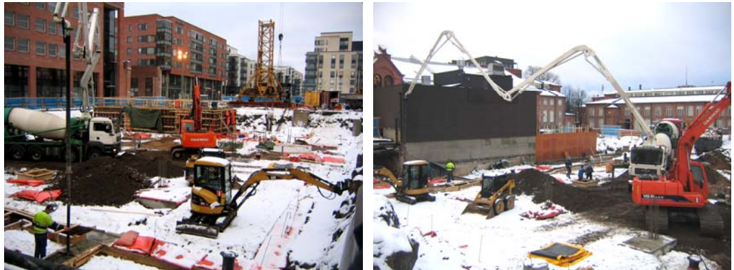
Kuva 20 ja 21 Willa Violan työmaan rajalliset työskentelytilat
