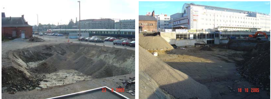
Kuvat 15 ja 16 Pendoliinon työmaan massojen vaihtoa
