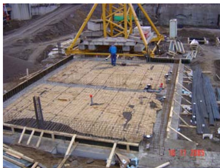
Kuva 5 Pendolinon väestönsuojan laatta valettuna
