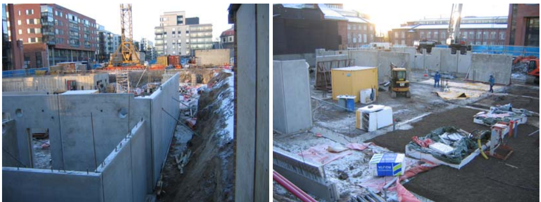
Kuva 28 ja 29 Elementtiasennus käynnissä Willa Violan työmaalla
