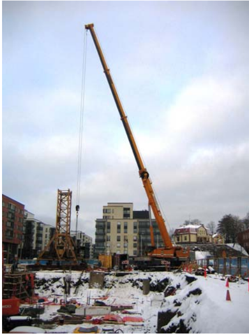
Kuva 27 Torninosturin kasaaminen käynnissä Willa Violan työmaalla
