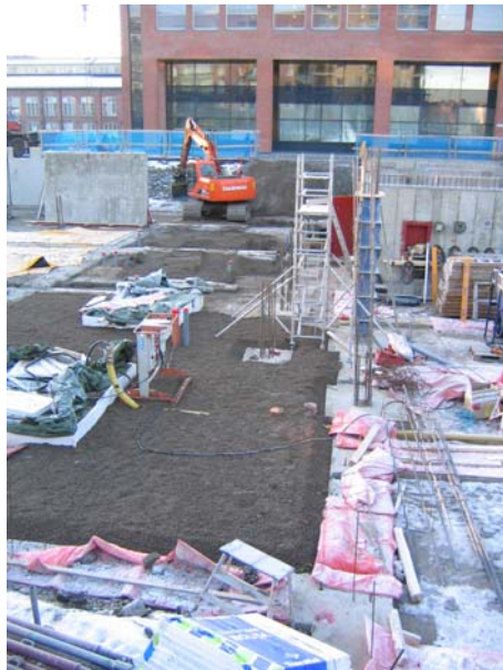
Kuva 22 Willa Violan työmaalta elementtien asennus alkanut
