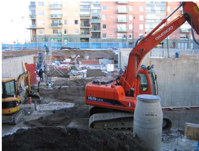
Kuva 23 Tila-ahtautta Willa Violan työmaalla. Elementtiasennus on alkanut.
