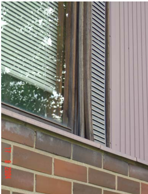
Kuva 11: Ikkunan karmi eteläseinällä
