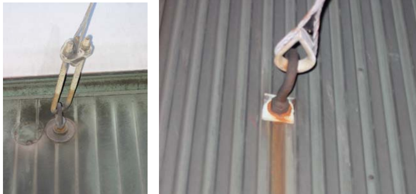
Kuvat 3 ja 4 Kuparilevyn päälle asennettuja kiinnikkeitä
