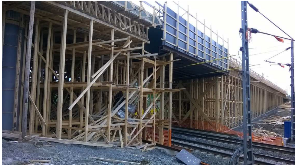
Kuva 5. Työmaan ympäristö luo omat riskinsä, jotka tulee ottaa huomioon budjettia laadittaessa. Kuvassa sähköistetty rautatie alittaa rakenteilla olevan sillan.
