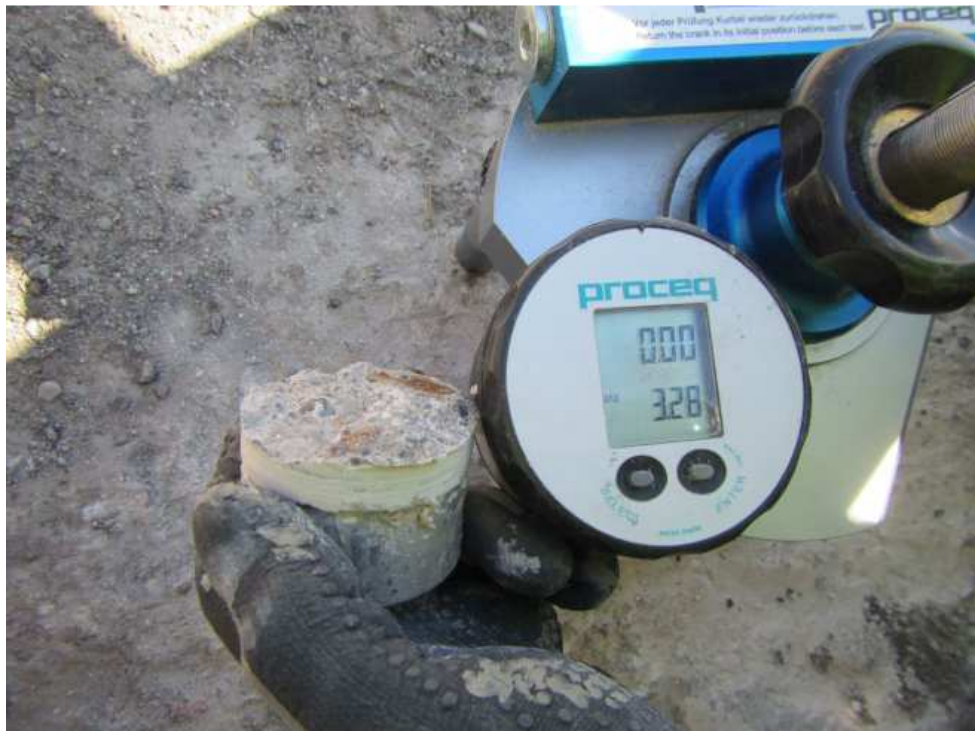
Kuva 8. Laadunmittausta ja -tarkkailua tehdään koko projektin ajan. Kuvassa kunnostettavan sillan vanhan kansilaatan vetolujuuden mittausta ennen piikkausta vetonappien avulla.
