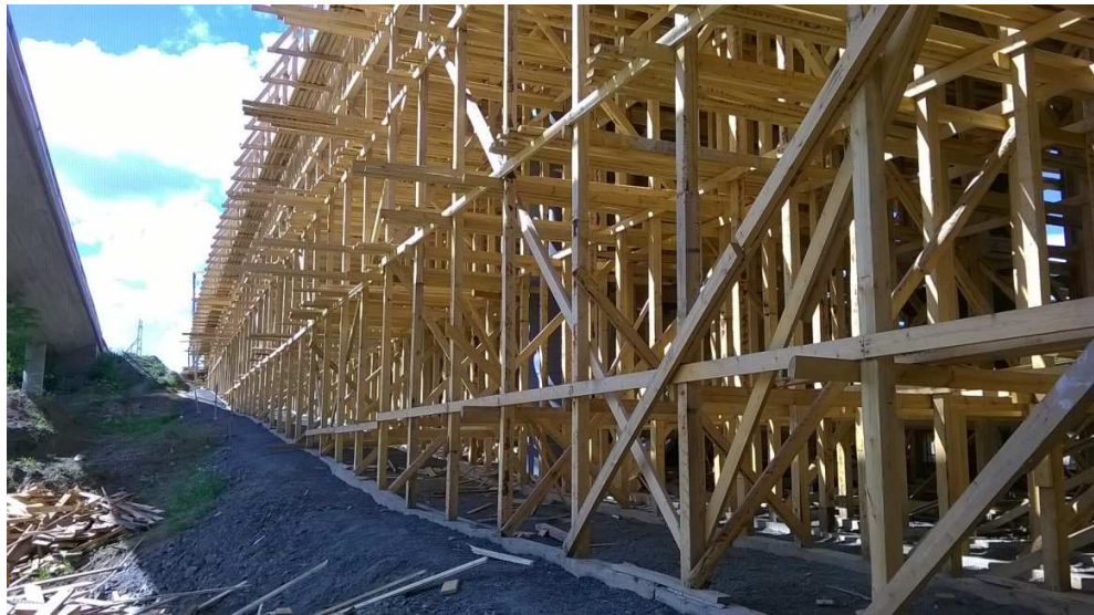
Kuva 4. Projektin kustannukset koostuvat monista osista. Kuvassa on rakennettavan sillan muotti ja telineet.
