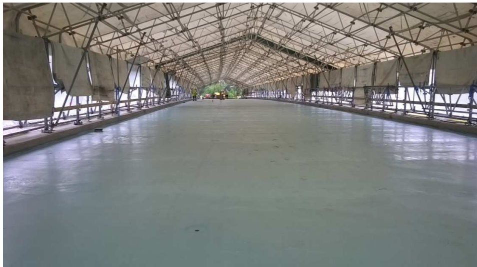
Kuva 3. Projektin eri vaiheet ovat kytköksissä toisiinsa, jolloin työvaiheen viivästyminen vaikuttaa seuraaviin työvaiheisiin. Kuvassa on epoksitiivistetty sillan kansi.
