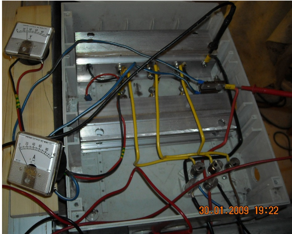
Kuva 48 Virta- ja jännitemittarit kiinnitettyinä siltaan
