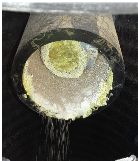
Kuvio 6. Lylysuon kemikalointiaseman ruovikuljetin syöttää ferrisulfaattia alapuolella pumpattavaan veteen (kuva: Helmi Karhumaa).
