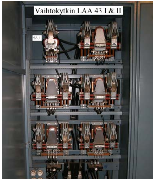
Kuva 37 Vaihtokytkin LAA 43 I & II
