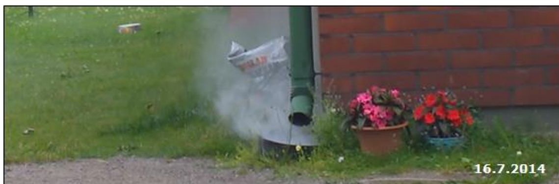
KUVA 5 Jätevesiviemäriin puhallettu savu osoittaa yhteyden rännikaivon
