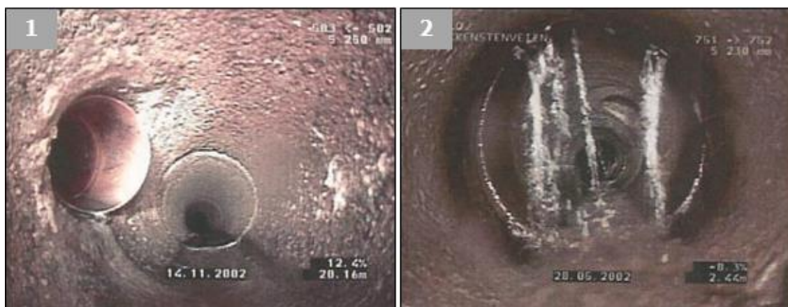
KUVA 3 Esimerkki TV-kuvauksella havaitusta viemäri liittymästä ja vuodosta (Vesi- ja viemäri laitostyöyhdistys 2005, 21–43)
