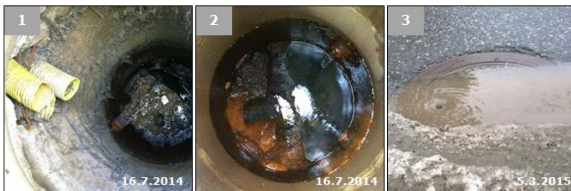
KUVA 4 Esimerkkejä vuotovesien reiteistä viemärikaivoon:
