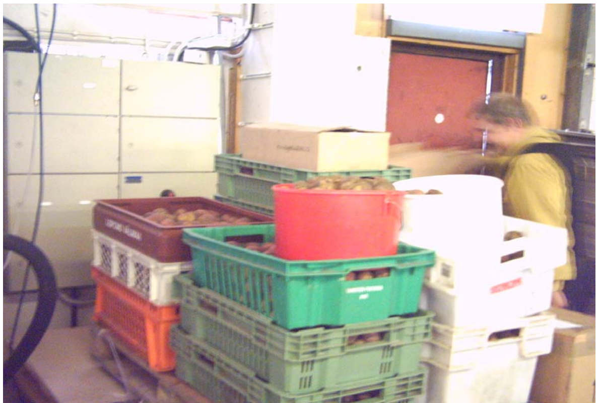
Kuva 6 Ryhmäkeskuksen huoltotila on tilapäisesti tukittu.
