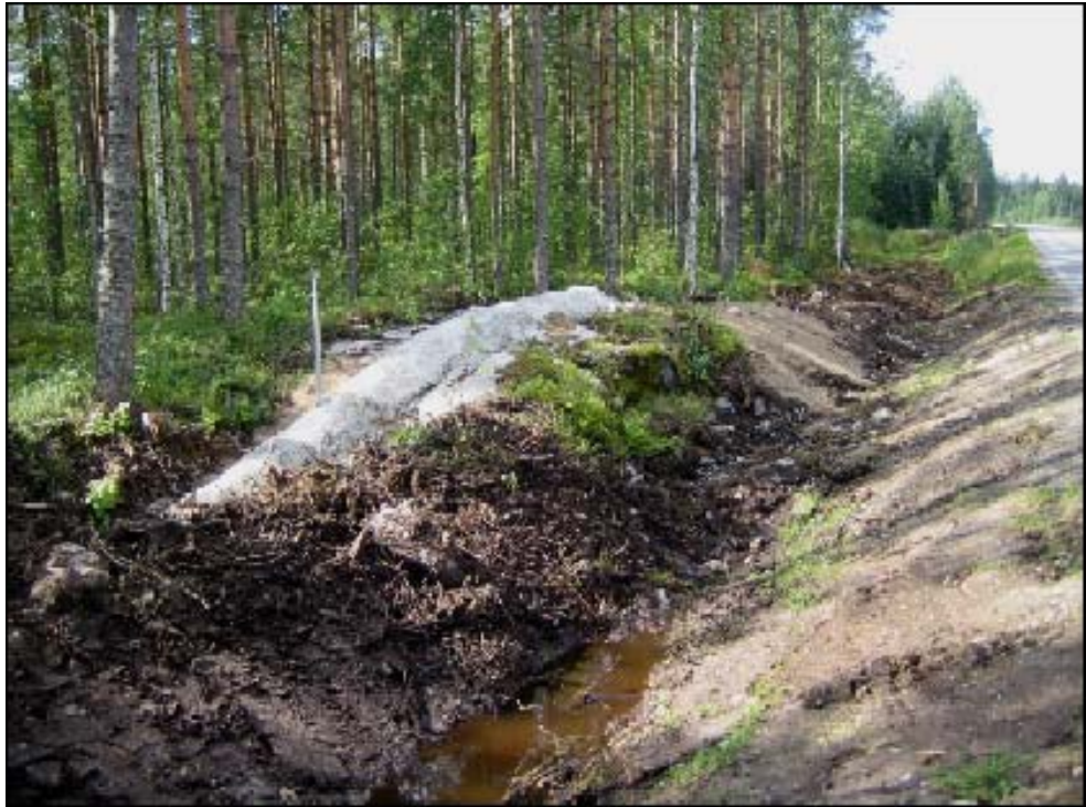
Kuva 5. Putken päälle on valettu betonikerros
