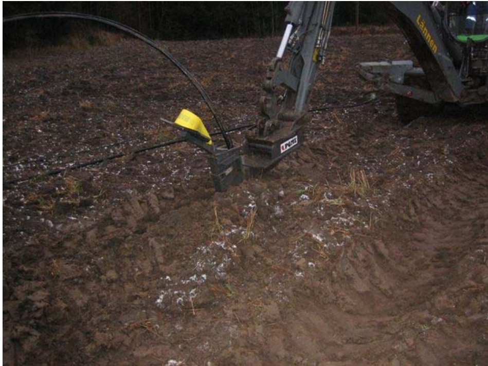
Kuva 2. Kaapelin aurausta pellolle (AXMK95 + puhelinkaapeli)
