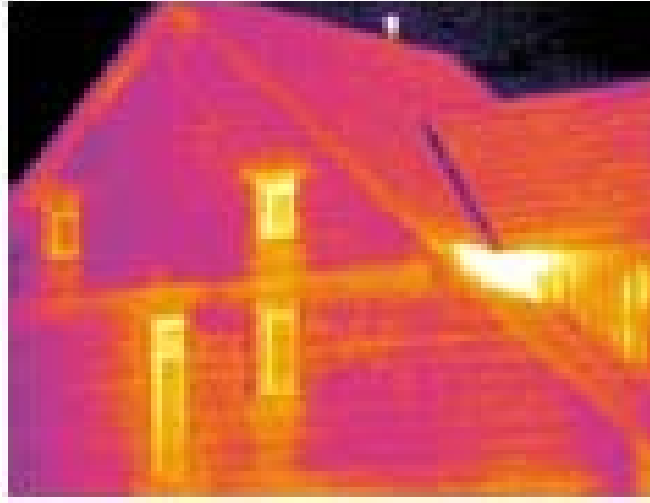
Kuva 25. Talossa olevien ikkunoiden alareunat ovat lämpimämpiä kuin kuvan seinät keskimäärin. /5/
