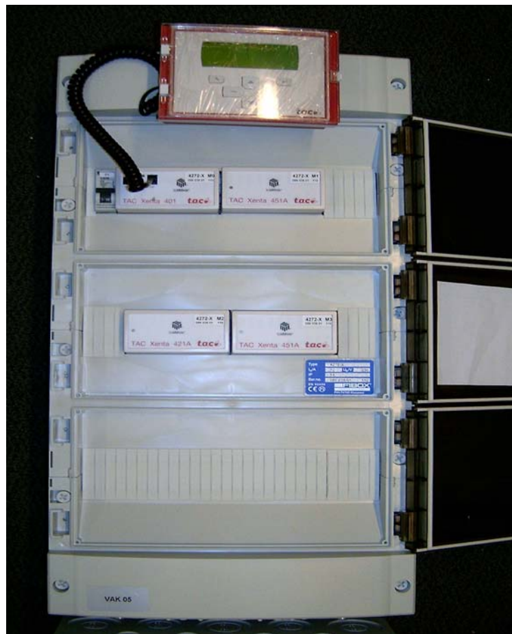
Kuva 9. Valvonta-alakeskuksen AK-kotelo /5/
