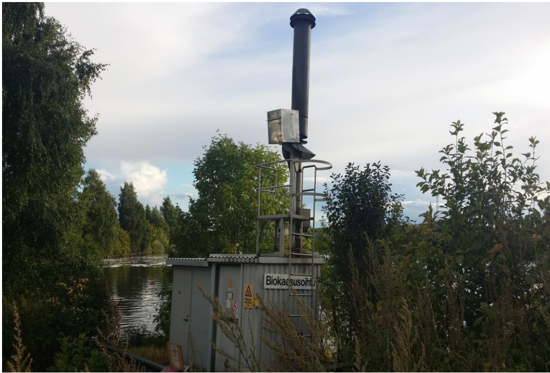
Kuva 5.7. Biokaasusoihtu.
