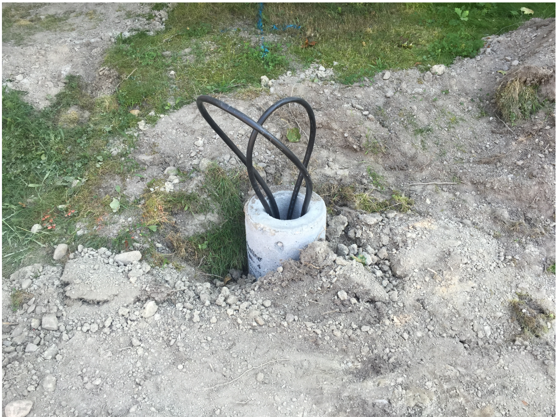
Kuva 2. Asennettu jalusta ja maakaapeli
