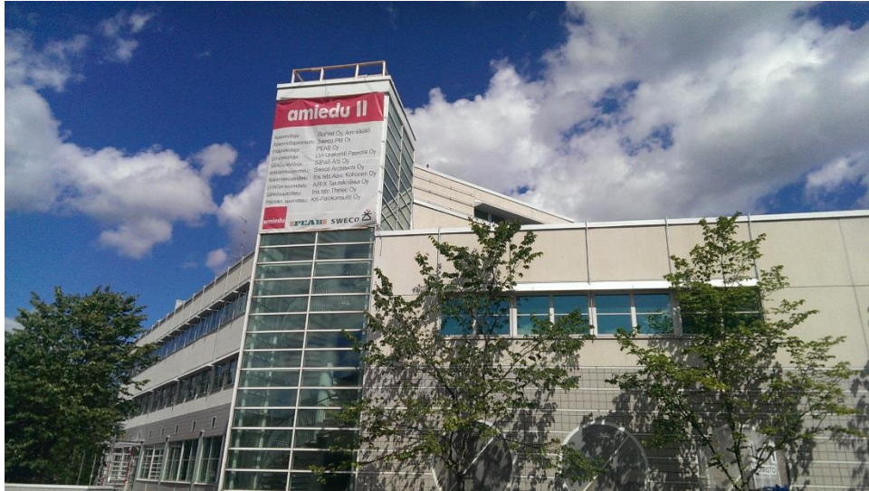
Kuva 4. Amiedu II -työmaan julkisivu. (Kuva: Matias Anttila)
