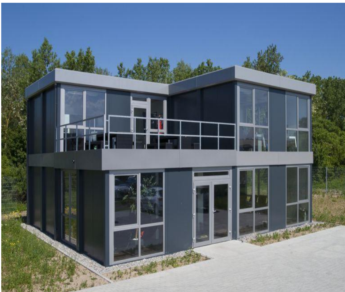
Kuva 2. Losbergerin rakentama toimistotilat [3]
